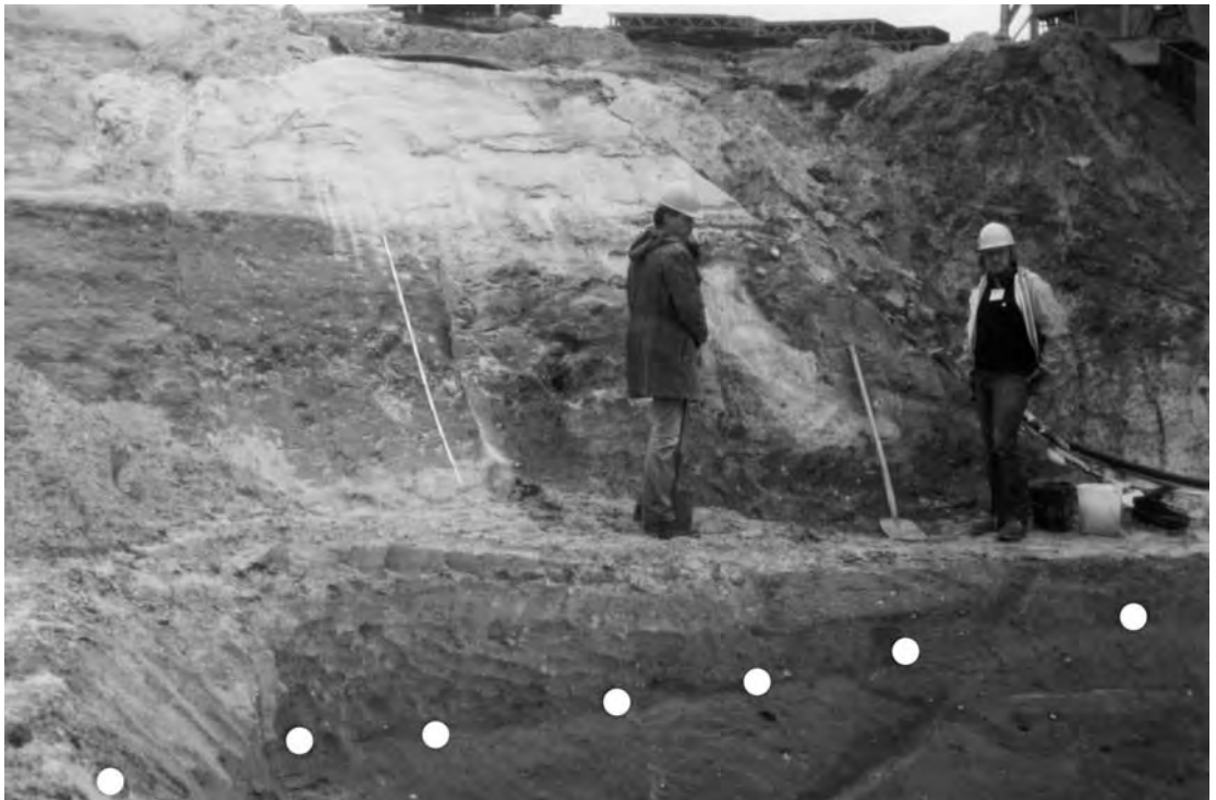
Abb. 2: Braunroter, toniger Geschiebemergel (Pr. 26, Tab.1 und Abb.1) (= ostbaltische Fazies der Drenthe-Hauptmoräne) direkt auf grauem, sandigen Geschiebemergel (Probe 27, Tab.1 und Abb.1), überlagert von weichselzeitlichem fluviatilen Sand der Emsniederung; zuoberst Düne. TK 25 Lingen-Süd Nr. 3509. Baugrube KKW Lingen 1984.
