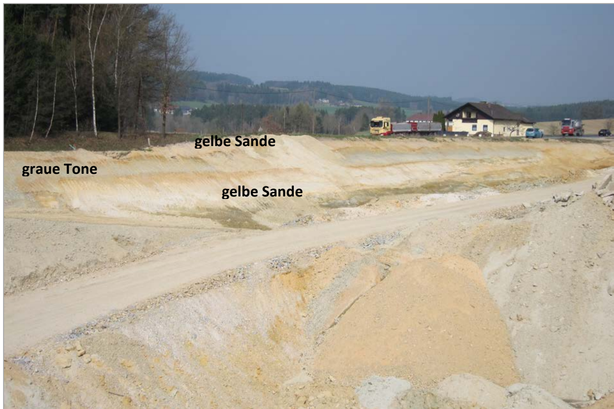
Abb. 2.1.1.9.: Bereich Unterflurtrasse Ganglsiedlung W-Wand – Übergang von der Kies- zur Sand- und Tonfazies des Freistädter Tertiärs (ÖK 33) (Foto: M. Peresson).
