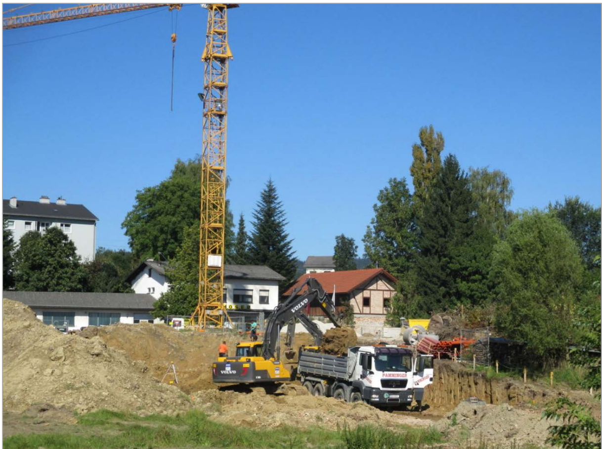
Abb. 2.3.1.1: Baugrube für das Alten/Pflegewohnheim und Gemeindezentrum in Ottnang ( www.meinbezirk.at )
