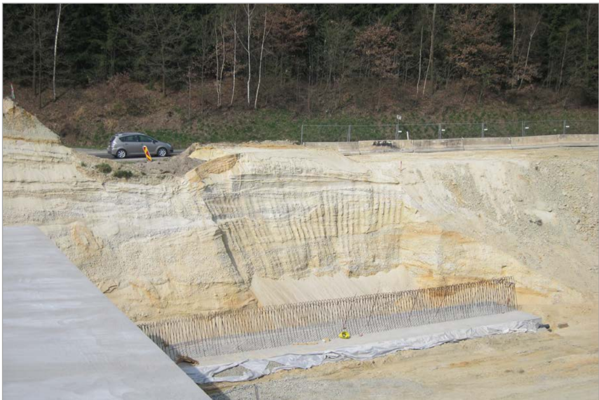
Abb. 2.1.1.8.: Bereich Unterflurtrasse Ganglsiedlung, W-Wand – Schrägschichtungssets im Kies des Freistädter Tertiärs (ÖK 33) (Foto: M. Peresson).
