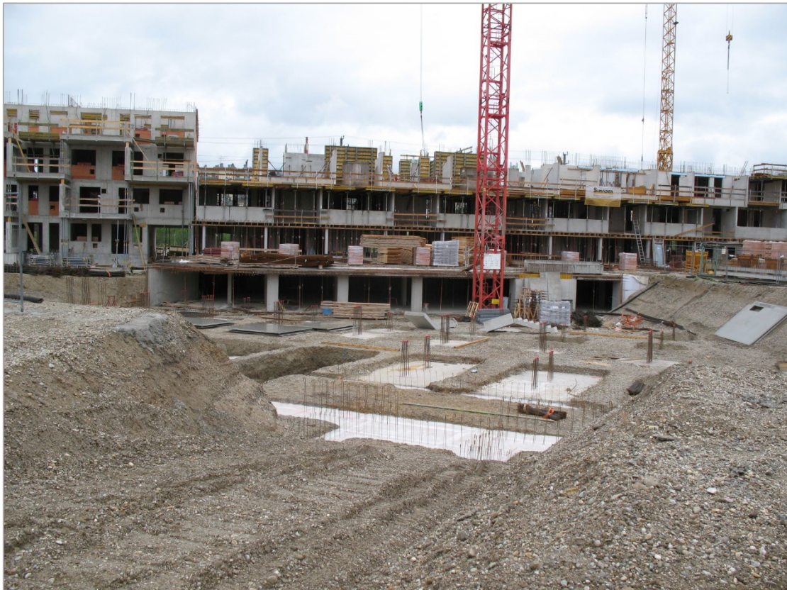
Abb. 2.3.3.5.: Nordostseite im Baustellenbereich Linz (Punkt 275_14): Unsortierte Niederterrassenkiese (Foto: Ch. Rupp).
