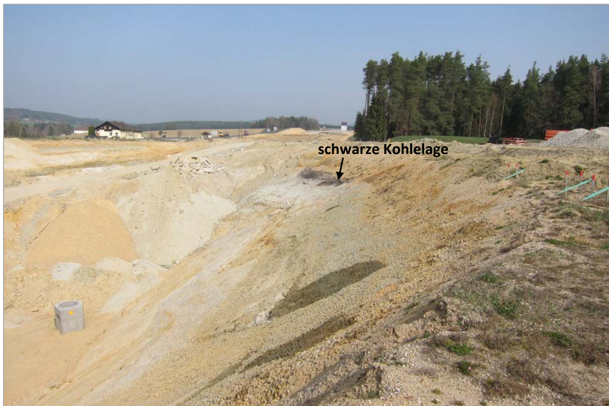
Abb. 2.1.1.10.: Bereich Unterflurtrasse Ganglsiedlung E-Wand – Kies- und Sandfazies des Freistädter Tertiärs mit schwarzer Kohlelage (ÖK 33) (Foto: M. Peresson).
