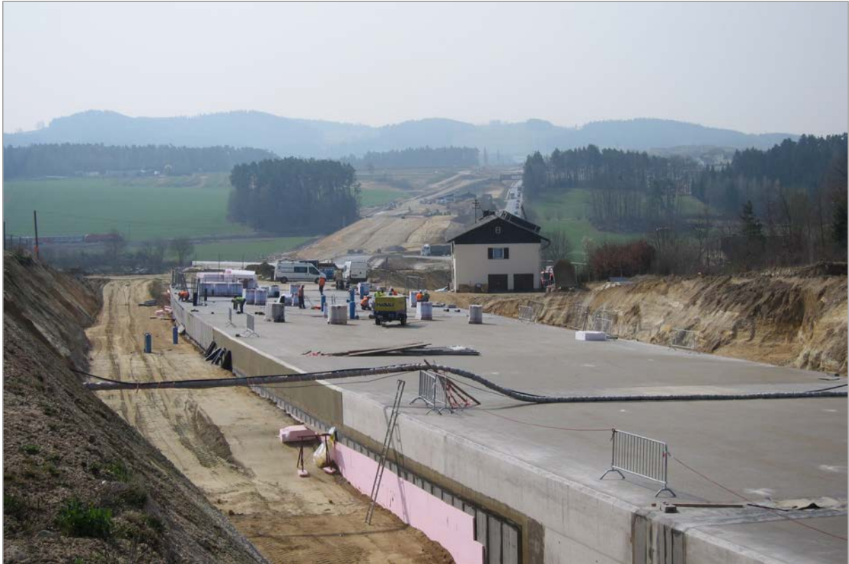
Abb. 2.1.1.20.: Bereich Unterflurtrasse Ganglsiedlung Blickrichtung S – fertiggestellte Streifenfundamente (ÖK 33) (Foto: M. Peresson).
