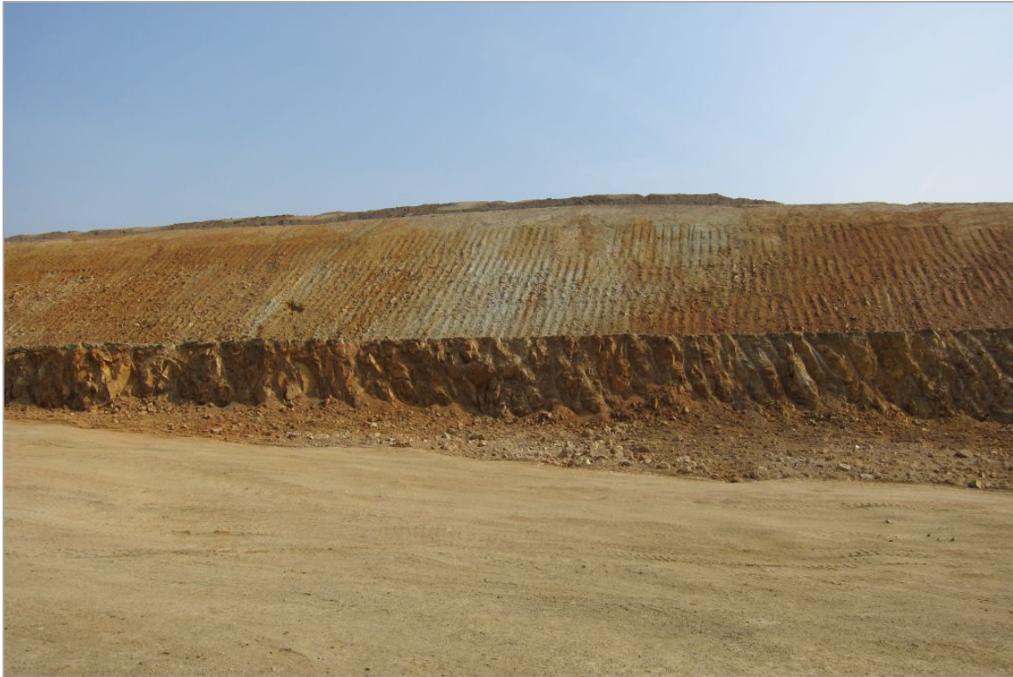
Abb. 2.1.1.25.: Bereich nördlich der Unterflurtrasse Ganglsiedlung, E-Wand: stark verwitterter Freistädter Granodiorit (Foto: M. Peresson).
