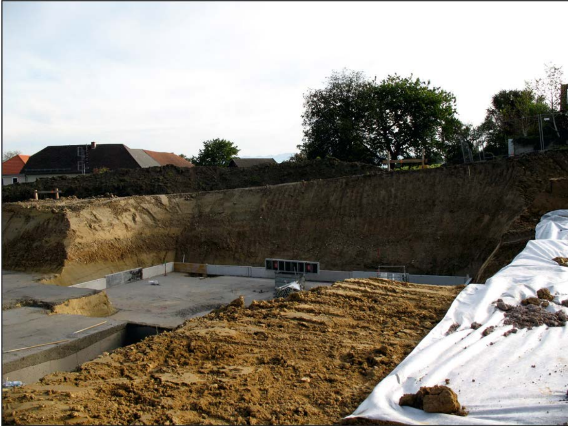
Abb. 2.3.1.6: Südwand der Baugrube in Ottwang im Hausruck (Foto: Ch. Rupp).
