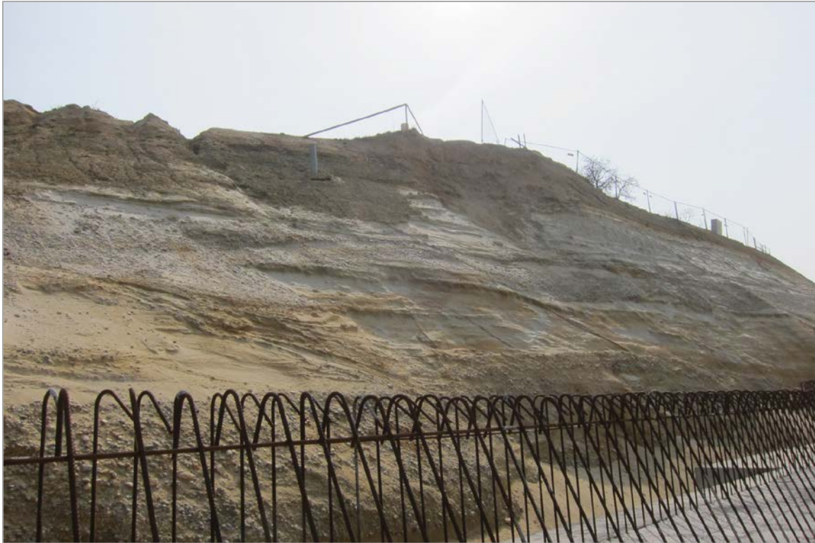
Abb. 2.1.1.15.: Bereich Unterflurtrasse Ganglsiedlung E-Wand – Schrägschichtungsets innerhalb der Sandfazies des Freistädter Tertiärs (ÖK 33) (Foto: M. Peresson).
