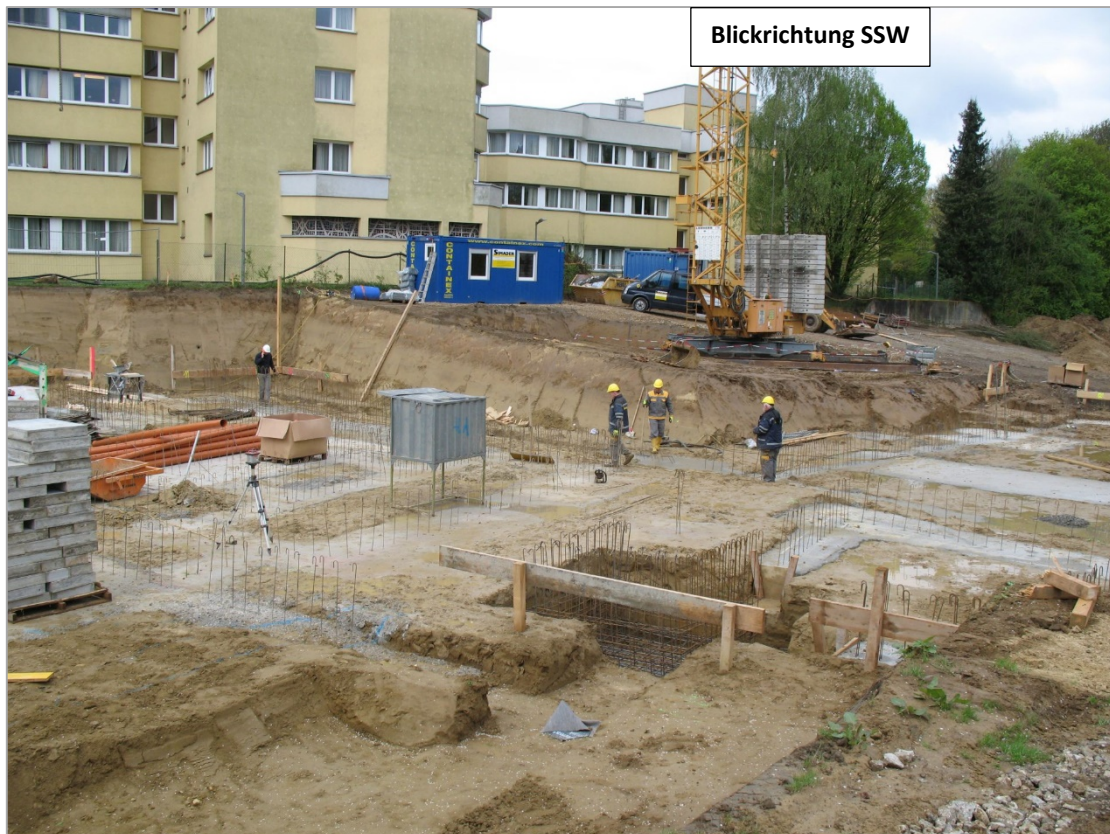
Abb. 2.3.2.6.: Südwestwand im Baustellenbereich in Leonding: Brauner Bodenhorizont am Top mit darunterliegendem, geringmächtigem gelblichen Löss (Foto: Ch. Rupp).
