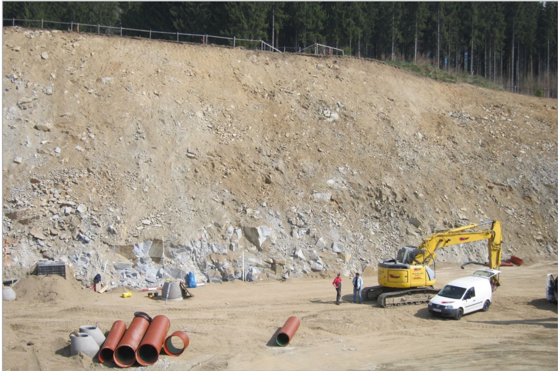
Abb. 2.1.1.35.: Bereich Freistadt Nord: Tiefgründig verwitterter (gelblich) Freistädter Granodiorit (Foto: M. Peresson).
