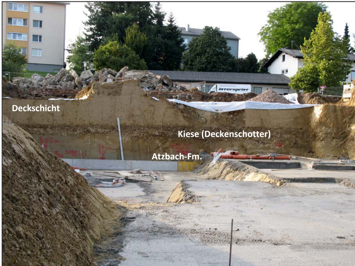
Abb. 2.3.1.5.: Westwand der Baugrube mit mächtigen Deckschichten im Hangenden, einer Kieslage in der Mitte der Aufschlusswand und sandige Sedimente der Atzbach-Formation im Liegenden (Foto: Ch. Rupp).
