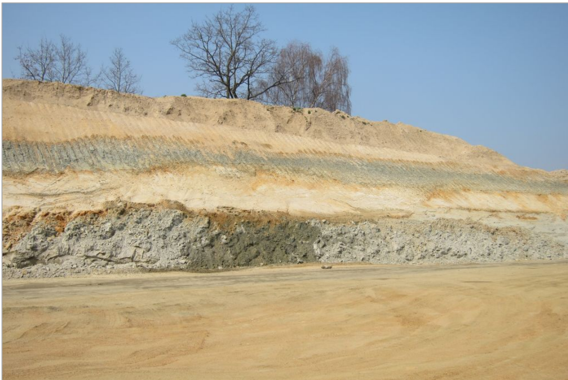
Abb. 2.1.1.28.: Bereich nördlich der Unterflurtrasse Ganglsiedlung, W-Wand: Sand (hellgelb)- und Tonfazies (grau) im Freistädter Tertiär (Foto: M. Peresson).
