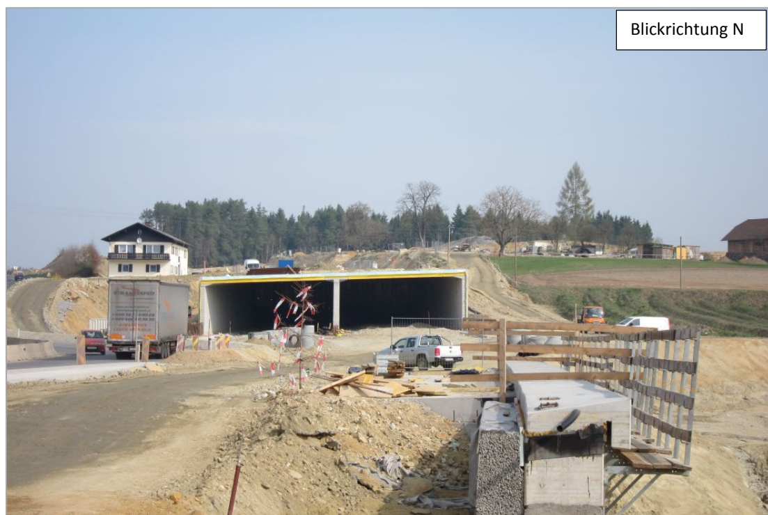
Abb. 2.1.1.6.: Unterflurtrasse Ganglsiedlung Blickrichtung N (ÖK 33) (Foto: M. Peresson).
