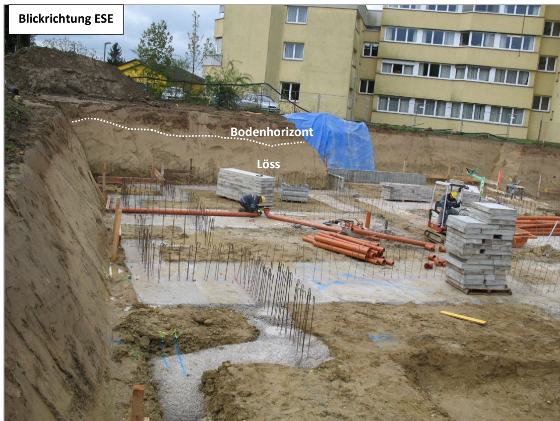
Abb. 2.3.2.5.: Ost- und Südostwand im Baustellenbereich in Leonding: Brauner Bodenhorizont am Top mit darunterliegendem, gelblichen Löss (Foto: Ch. Rupp).
