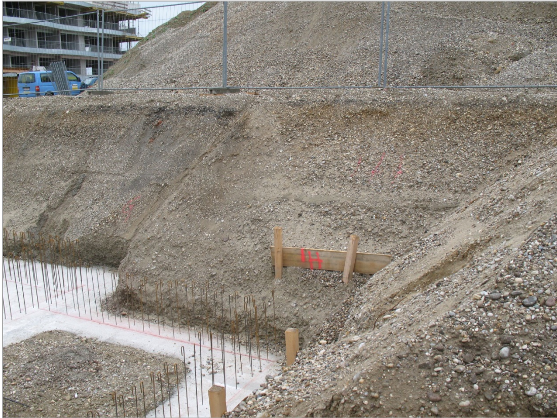
Abb. 2.3.3.6.: Nordostseite im Baustellenbereich Linz (Punkt 275_14): Unsortierte Niederterrassenkiese mit Sandzwischenlagen (Foto: Ch. Rupp).
