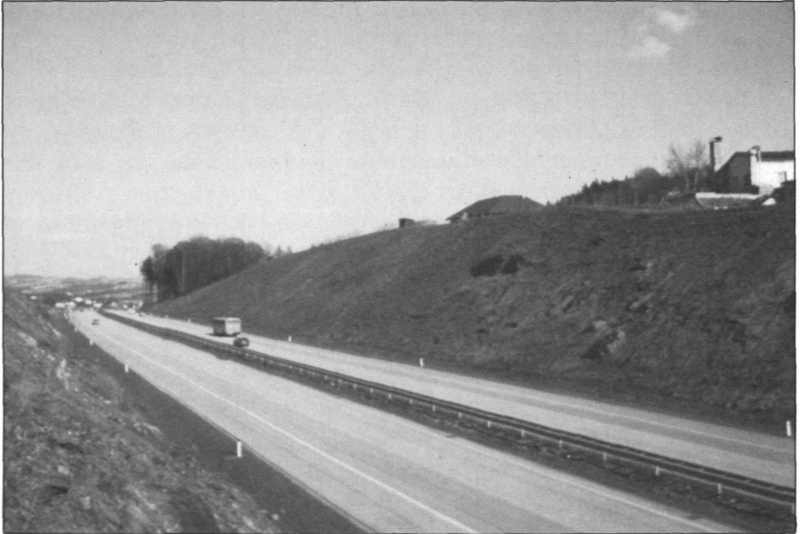
Abb. 13: Aufschluß VI b: Autobahneinschnitt auf dem Trefflinger Sattel, Südseite. Vorne Durchragungen von Weinsberger Granit mit Übergängen zu „Grobkorngneisen“; dahinter im glatten Hangbereich, heute verwachsen, „Linzer Sande“ und „Phosphoritsande“.
