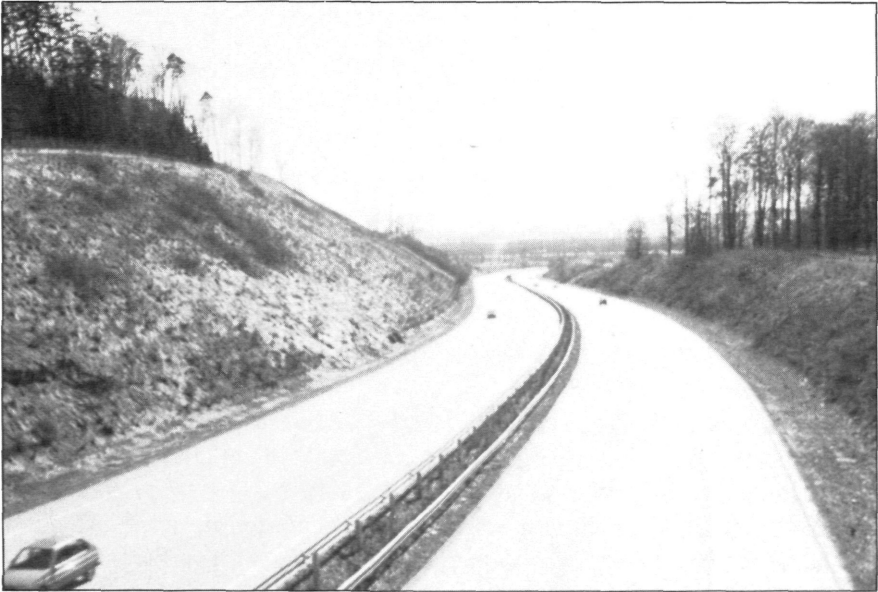
Abb. 3: Aufschluß I: Autobahneinschnitt Katzbach, Blickrichtung Linz. Auf der linken Bildseite ist der heutige Zustand im Bereich der unter I b und im Hintergrund unter I a beschriebenen Abschnitte zu sehen.
