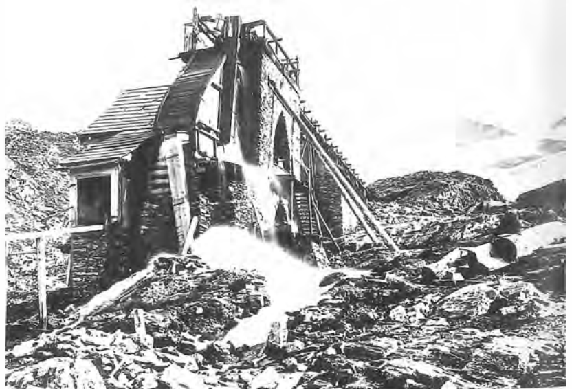
Abb. 10: Radhausberg des Schrägaufzuges am Hohen Goldberg um 1885.
