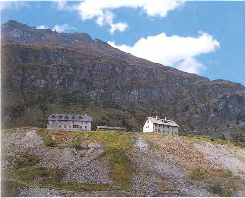
Abb. 13: Gasteinertal; ehemalige Aufbereitungsanlagen beim Imhofstollen, 1993. Foto: R. Seemann
