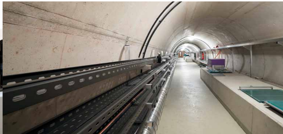
Seismischer Stollen zur weltweiten Messung von Erdbeben Seismic tunnels for the worldwide measurement of earthquakes
