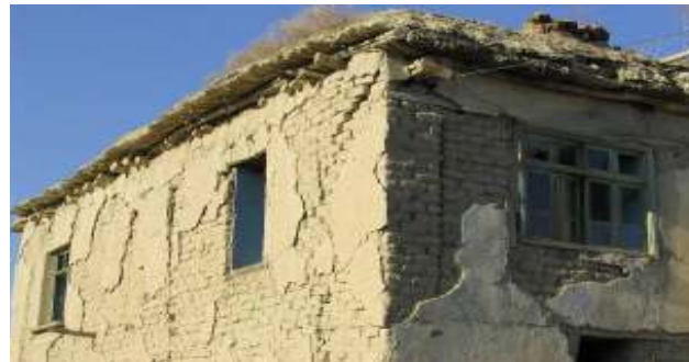
(c) Kerpik structure (Aksehir, 2003) (Source: H. H. Korkmaz, S. Z. Korkmaz, M. S. Donduren)
