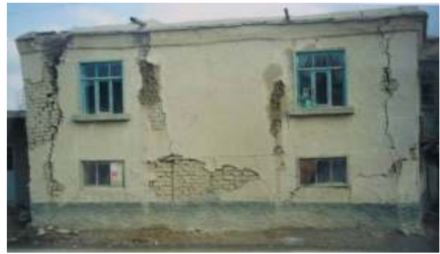
(b) Kerpici structure (Aksehir, 2003) (Source: H. H. Korkmaz, S. Z. Korkmaz, M. S. Donduren)
