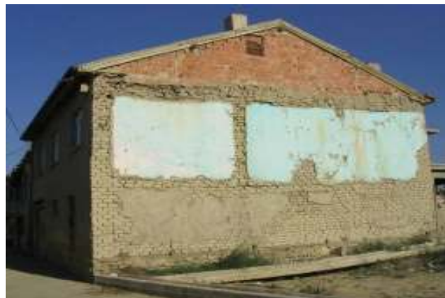
(c) Neighbouring structure (Source: H. H. Korkmaz, S. Z. Korkmaz, M. S. Donduren)
