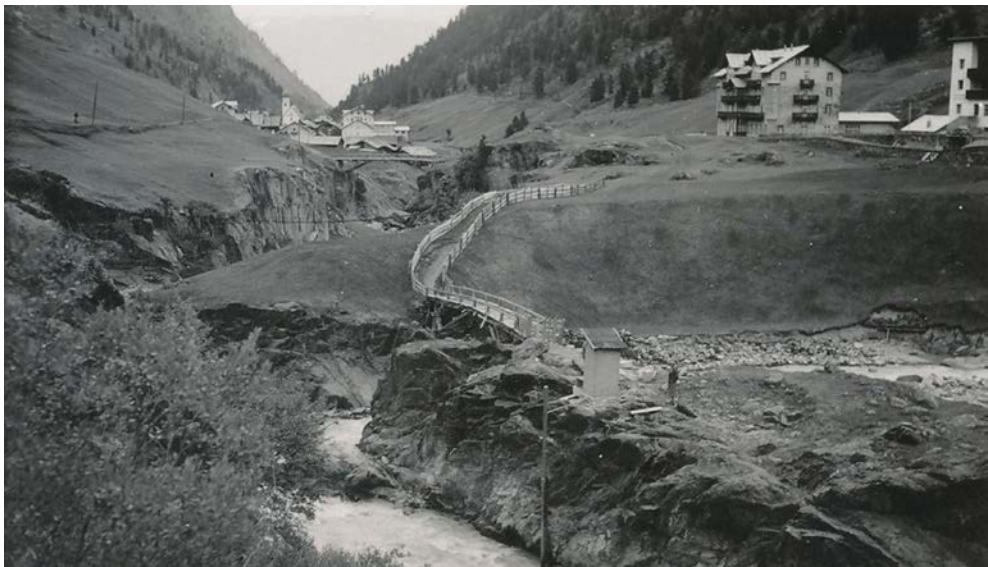
Abb. 3: Der Pegel Vent/Rofenache (vor 1936) auf dem Felssporn zwischen der Rofenache und der Spiegelache, auch Niedertalbach genannt. Pegelausstattung: Lattenpegel, Registrierpegel nach Schwimmerprinzip, begehbare Häuschen (Foto: Hydrographischer Dienst Tirol)
