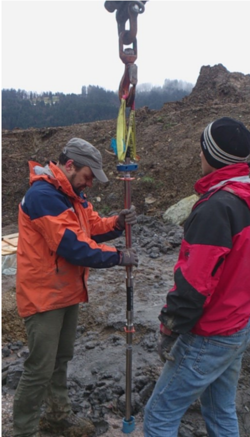
Abb. 47: Pechgraben – Inclinometerinstallation
