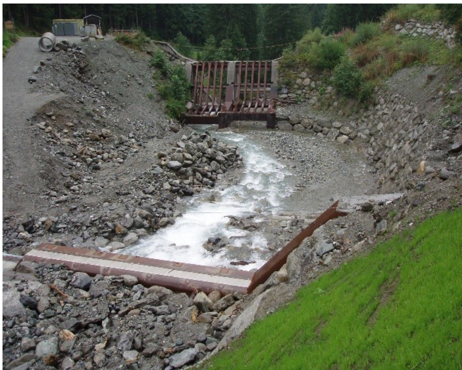
Abb. 66: Suggadinbach – Überblicksfoto der Geschiebemesstation Suggadinbach
