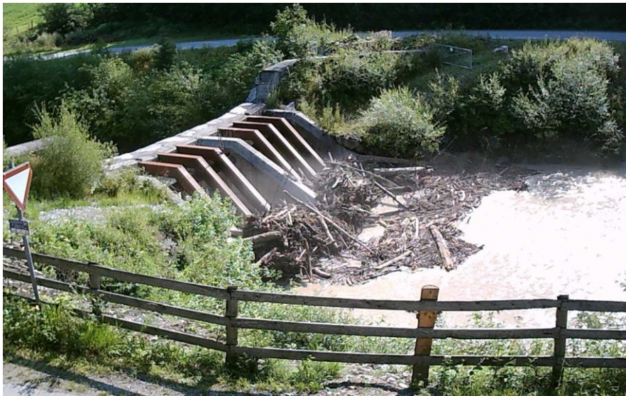
Abb. 61: Schlapftorsperre – Ansammlung von Wildholz in der Schlapftorsperre aufgenommen mit der IP-Kamera
