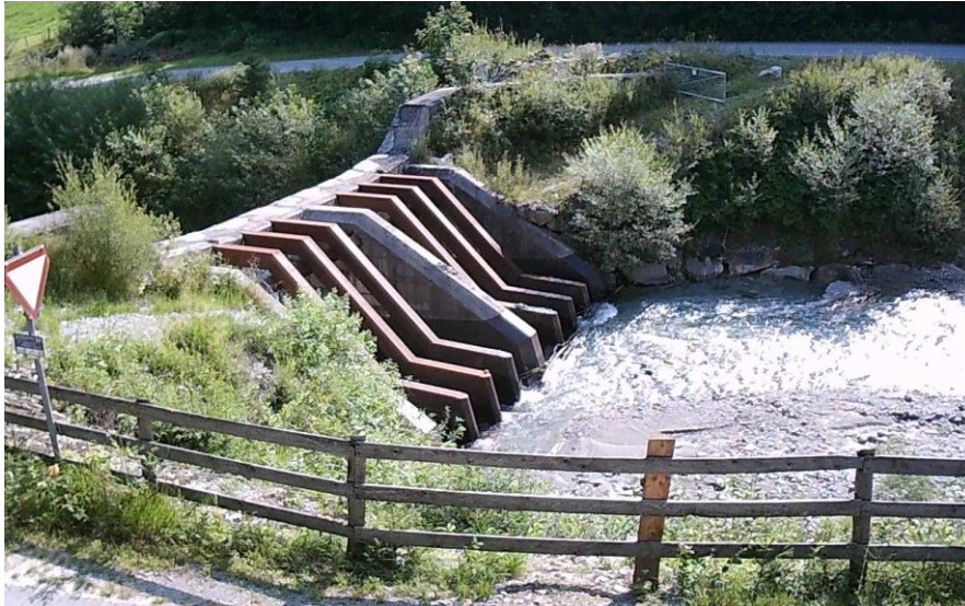
Abb. 60: Schlapftorsperre – Schlapftorsperre ohne Wildholz
