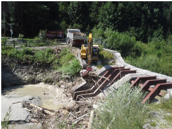
Abb. 59: Schlappfordsperre – Wildholzentfernung aus der Schlappfordsperre
