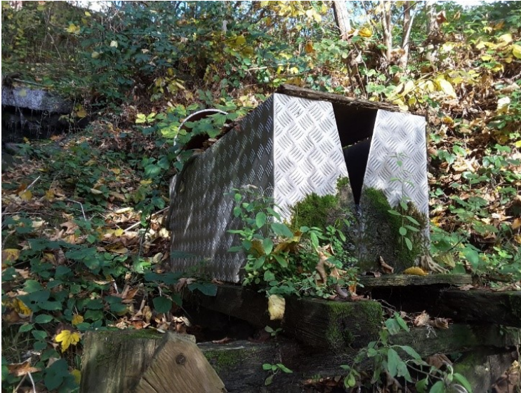
Abb. 16: Foto der Tiefdrainage
