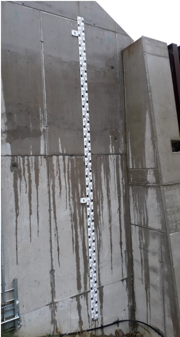
Abb. 74: Autenberggraben – Lattenpegel im Rückhaltebecken
