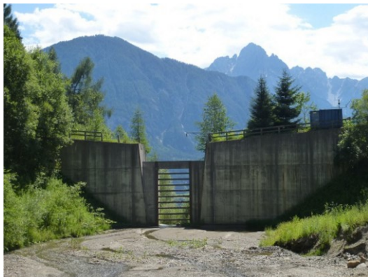
Abb. 55: Wartschenbach - Abflussmessstelle
