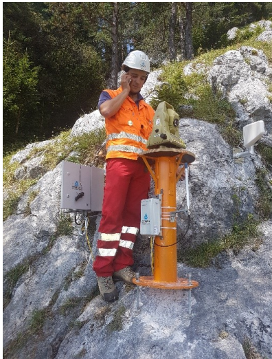
Abb. 41: Pürggerwand - vollautomatische Totalstation ohne Abdeckung
