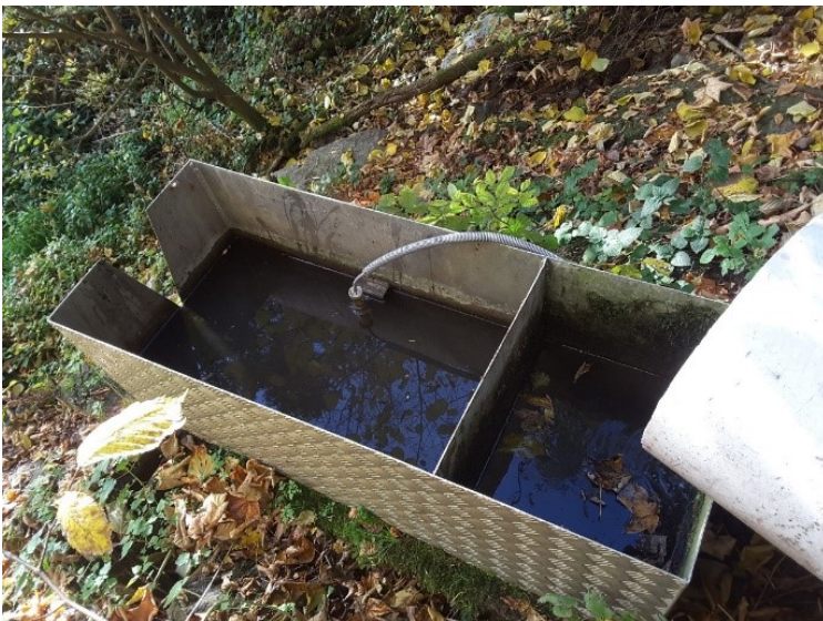
Abb. 18: Foto der Tiefdrainage
