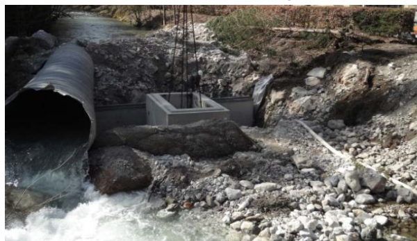
Abb. 71: Johnsbach – Geschiebetransportmessstelle Johnsbach während des Baus
