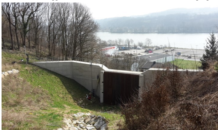
Abb. 73: Autenberggraben – Übersichtsfoto des Rückhaltebeckens
