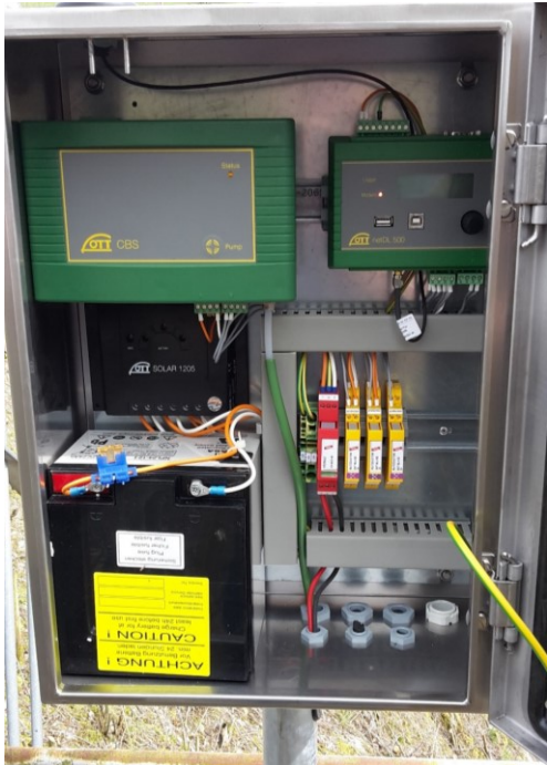
Abb. 80: Reingrubergaben - Datenübertragungsbox
