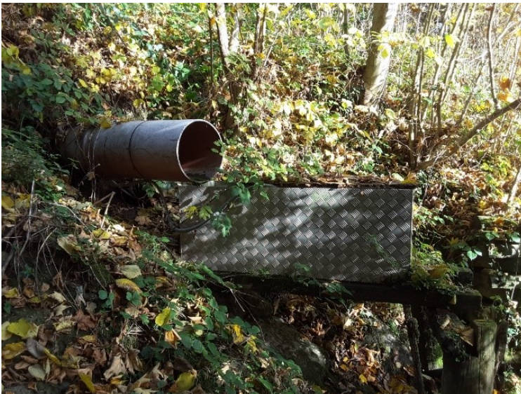
Abb. 17: Foto der Tiefdrainage
