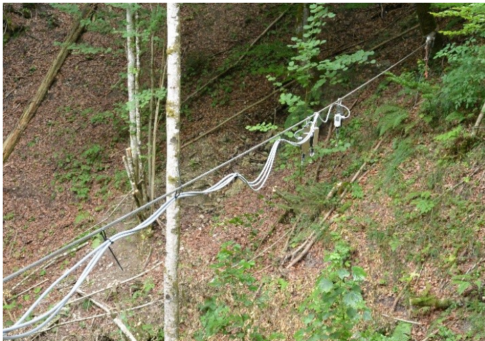
Abb. 64: Gallenzerkogelmure – Abreißschnüre im Graben der Gallenzerkogelmure
