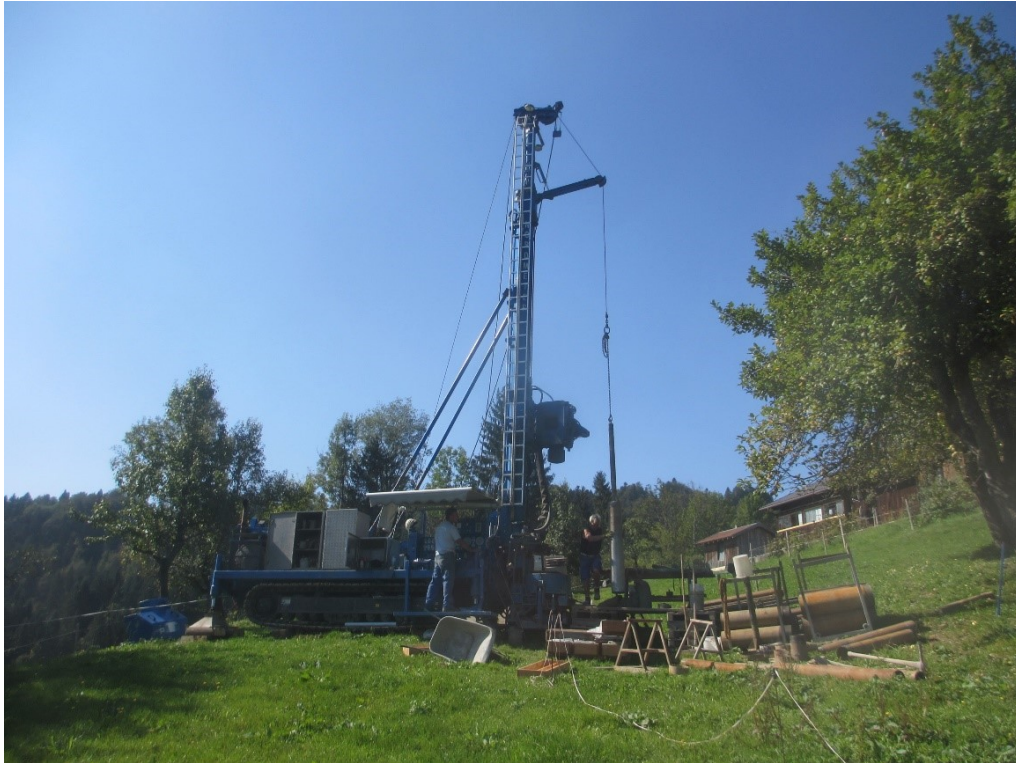
Abb. 23: Unterrain – Bohrung zur Inclinometerinstallation
