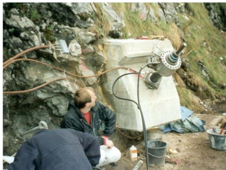
Abb. 10: Breitenberg – Einbau eines Messankers
