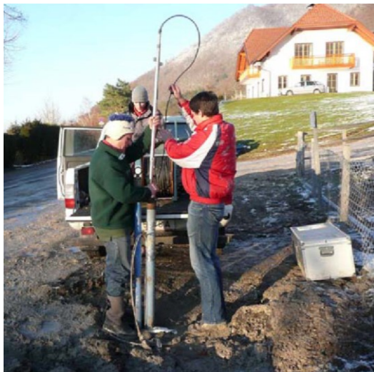
Abb. 44: Gschlifgraben – Inclinometermessung im unteren Bereich des Gschlifgrabens
