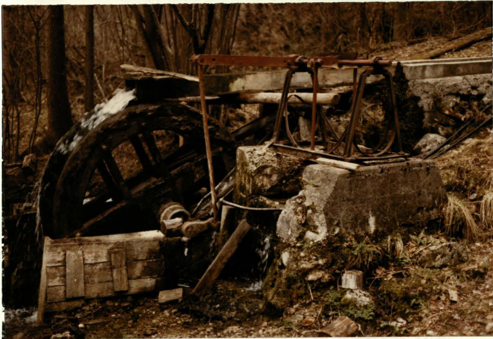
Bild 6 : Fassung und Pumpwerk für die Wasserversorgung von Draurain (Quelle Nr. 59)
