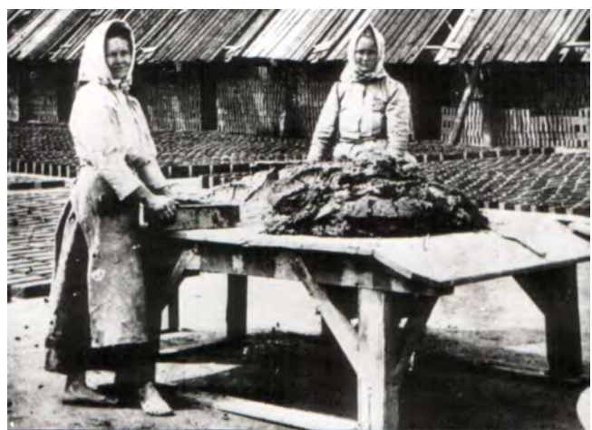
Abb. 20. In den 1950er-Jahren von Fa. Wienerberger nachgestellte Szene: die Ziegel werden geschlagen.
