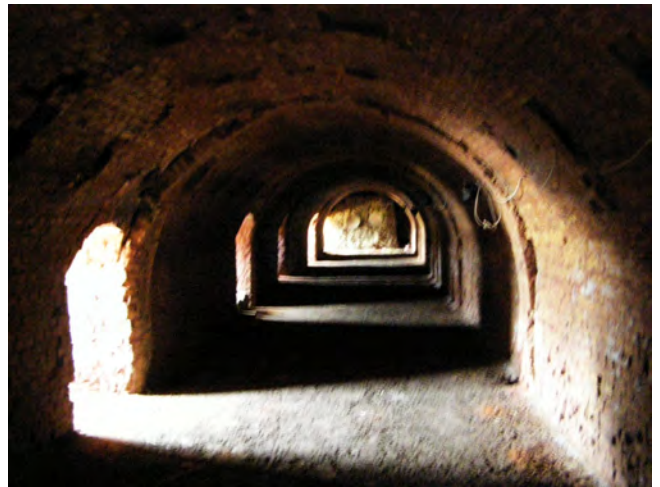
Abb. 35 Ofenkanal im Ringofen Neubau-Kreuzstetten
