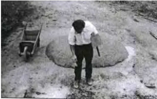
Abb. 15. Der Ziegelschläger bereitet den Lehm vor 39 .
