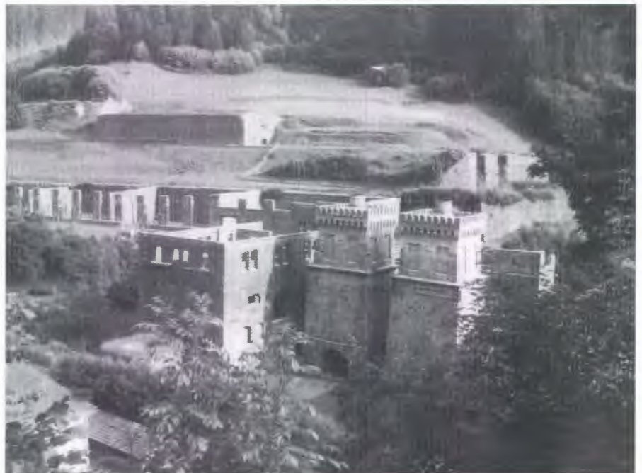
Abb. 3: Eisenwerk in Heftl, Sept. 1986. Rechts oben: Erzmagazin; davor: Holzkohlenmagazin; rechts vorne: Hochöfen. Foto: W. Wieland.
