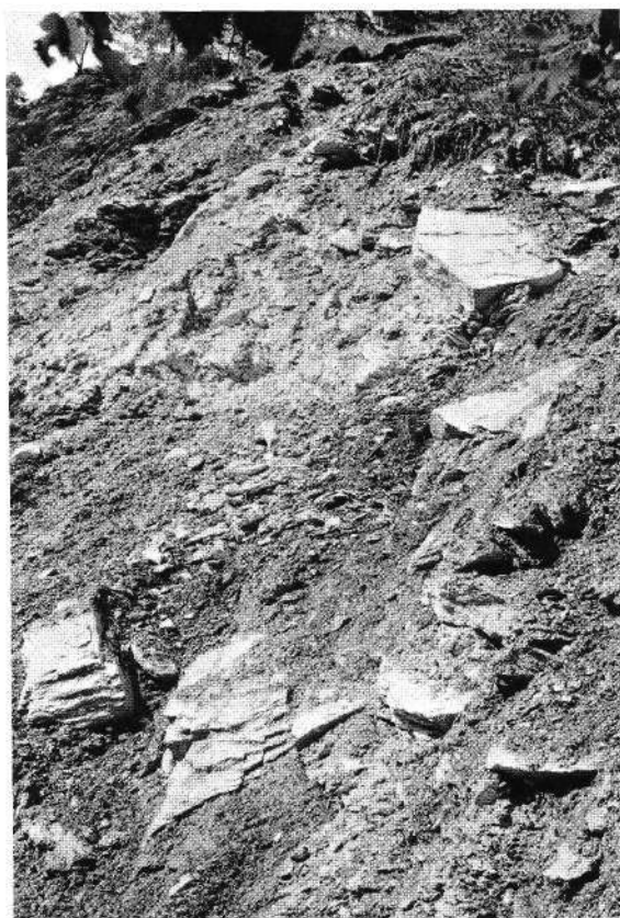
Abb. 18: Die in gewissen Bereichen sehr stark entfestigten und nur mehr als Lockergestein anzusehenden Phyllite reagieren beim Instabilwerden mit Rotationsrutschungen.
