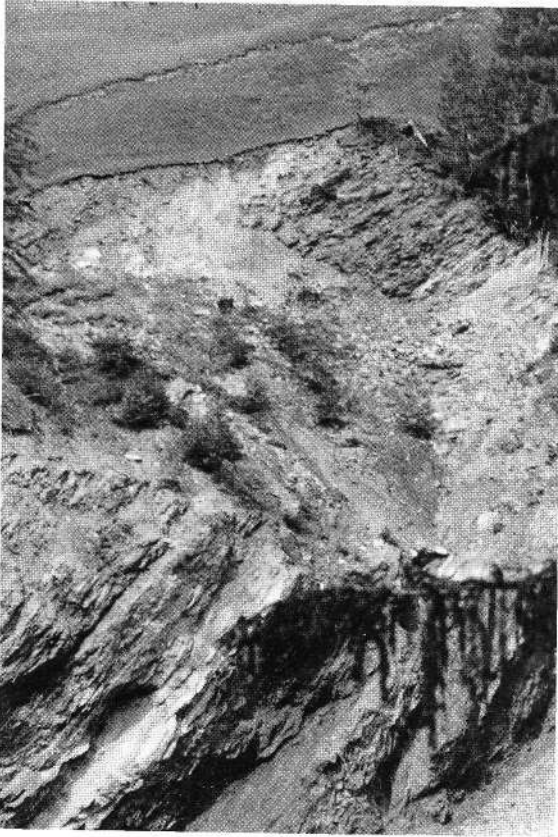
Abb. 17: Blick auf die übersteilte Talzuschubsstirn im mittleren östlichen Bereich der Talzuschubsmasse; zum Unterschied zu den westlich anschließenden Zonen (s. Abb. 16) liegen die Karbonatphyllite einschließlich der eingelagerten Chlorit-Karbonatphyllite in einer schiefrigen Gebirgsfazies vor. Ein Abgleiten einer größeren Bruchmuschel im 100-m-Bereich deutet sich bereits durch einen größeren Riß oberhalb der derzeitigen Abrißkante an.
