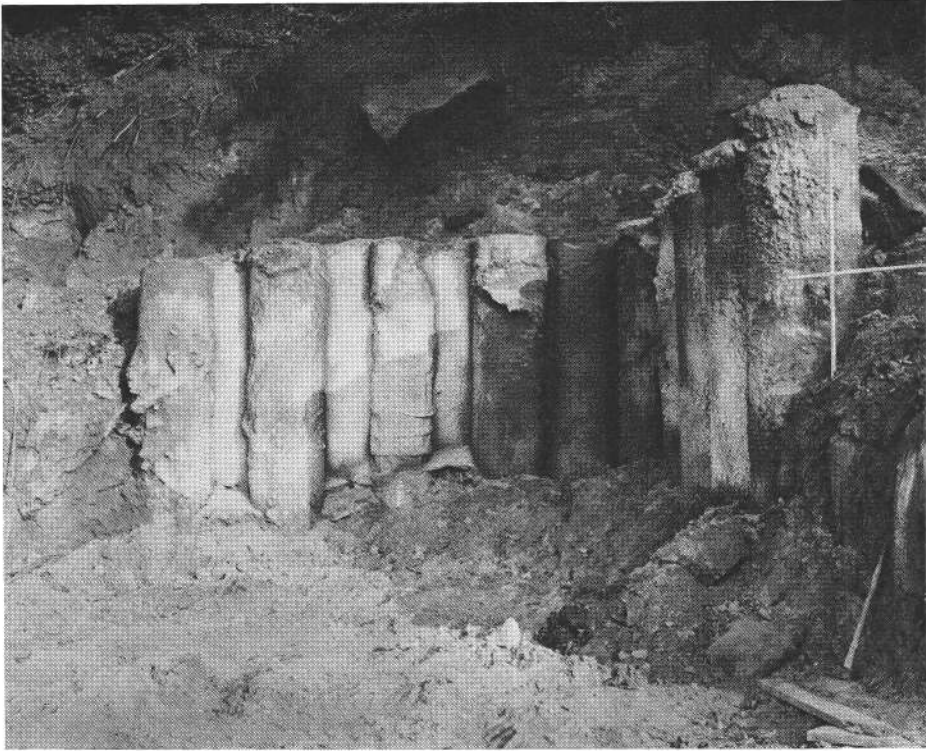
Abb. 5: Bohrpflahlwand zur Hangsicherung im Voreinschnitt Nord, vor Tunneldurchschlag. Über den Pfählen sind Bergsturzböcke aus Roterz sichtbar, die in kohäsionslosem Sand (Verwitterungsprodukt der Roterzschichten i. w. S.) schwimmen
