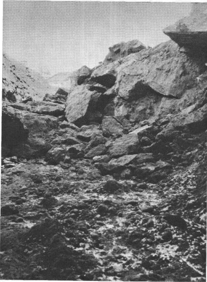
Abb. 4: Blick vom Nordportal gegen Norden (Dezember 1975). Im Vordergrund gut gerundeter Flysch-Schotter auf Unterbausohle, im Hintergrund riesige Bergsturzböcke aus Roterzschichten i. e. S. und Unterem Lithothamnienkalk
