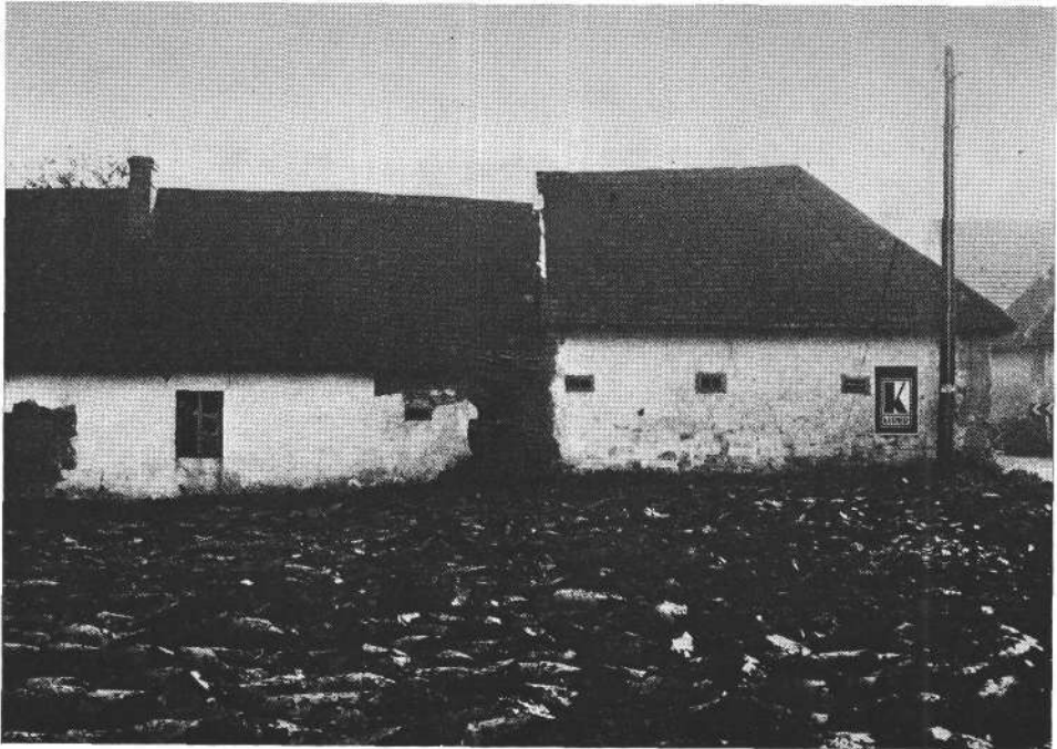
Abb. 16: Stark beschädigtes Haus am nördlichen Ortsrand von Platt
