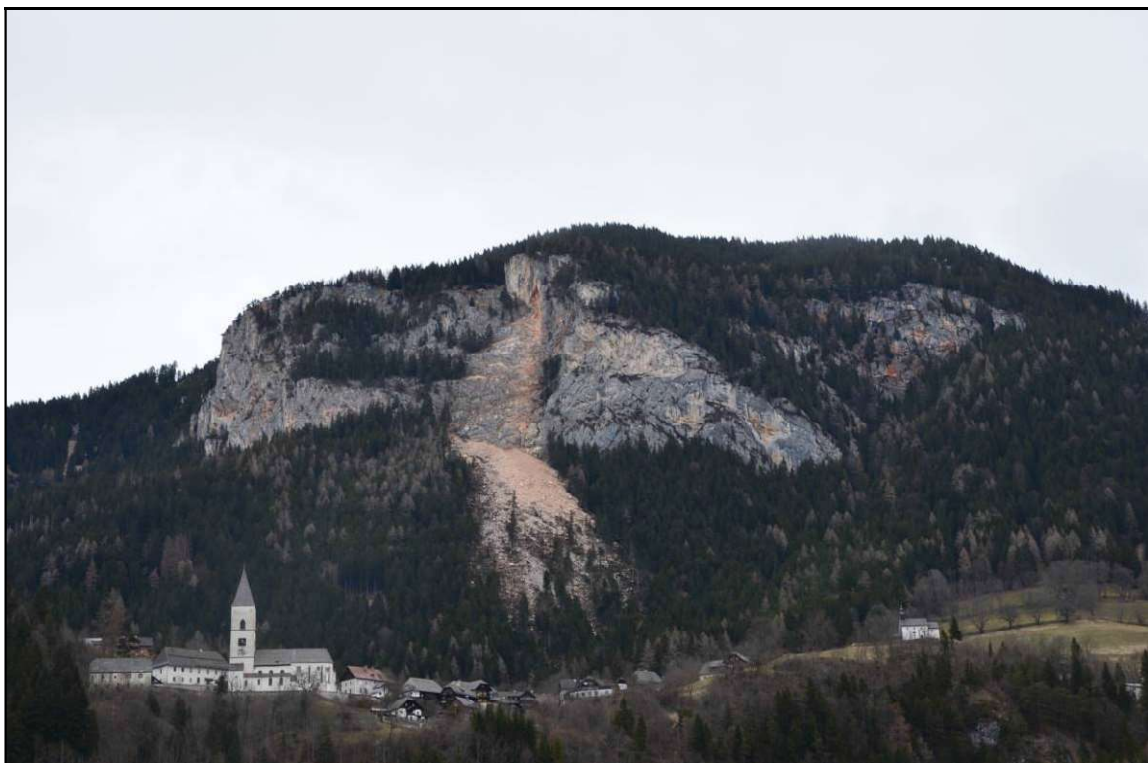
Abb. 1: Felssturzbereich Pürgger Wand.
