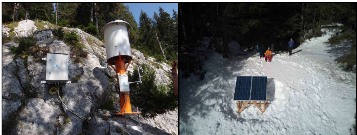
Abb. 7: Totalstation (links) und Solaranlage unterhalb der Pürggerwand.
