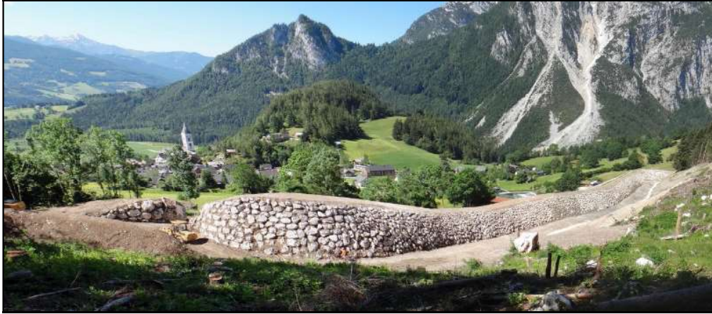
Abb. 9: Fertiggestellter Steinschlagschutzdamm Pürgg.
