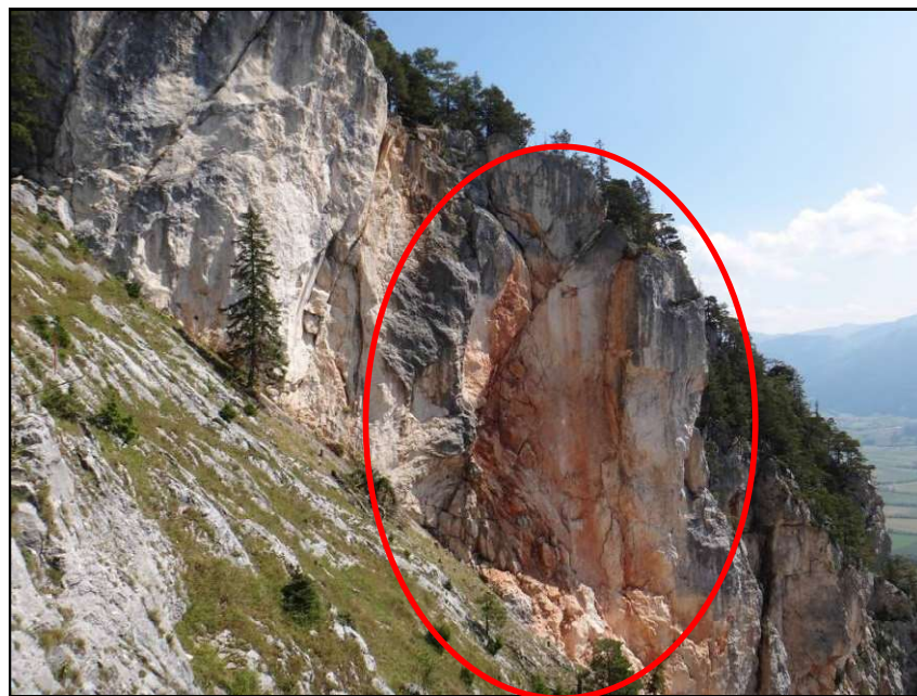
Abb. 3: Pürggerwand, Aufnahme vom 22.08.2018, (Ausbruch rot markiert).
