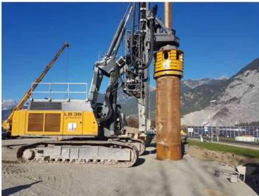
Kellybohranlage (bis 49 m uGOK)
