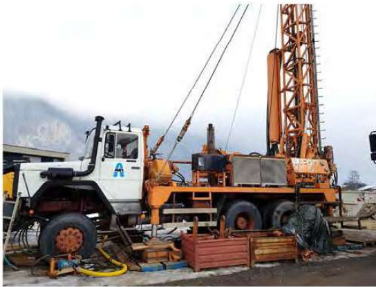
RB50-Bohrgerät, Gerät 7502, LKW 6414, Bauweise Nr. 9506, 5267
