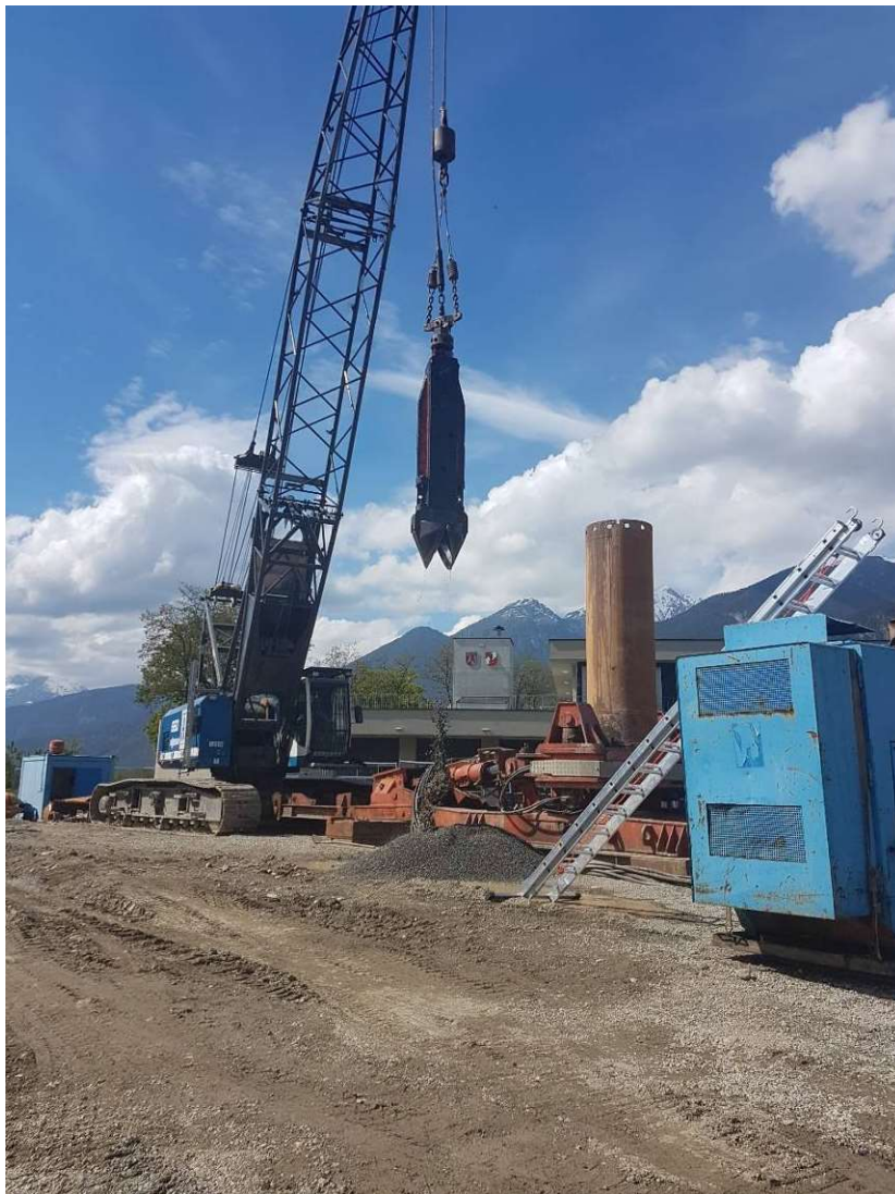
Greiferbohranlage (von 49 bis 112 m uGOK)
