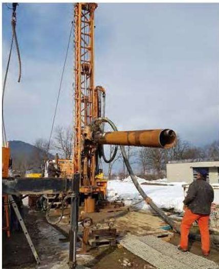
Stahlrohr DN 500, Doppelwandgestänge für Imlochhammer
