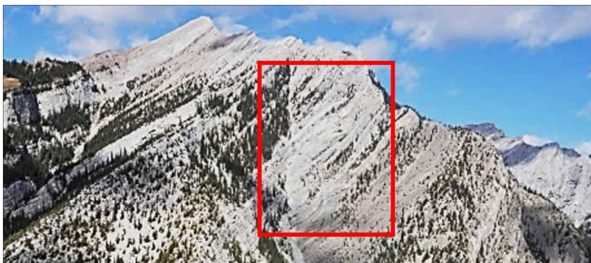
Abb.5: Ansicht der potenziellen Felsgleitung (Foto von M. Jakob, BGC, 2014)
