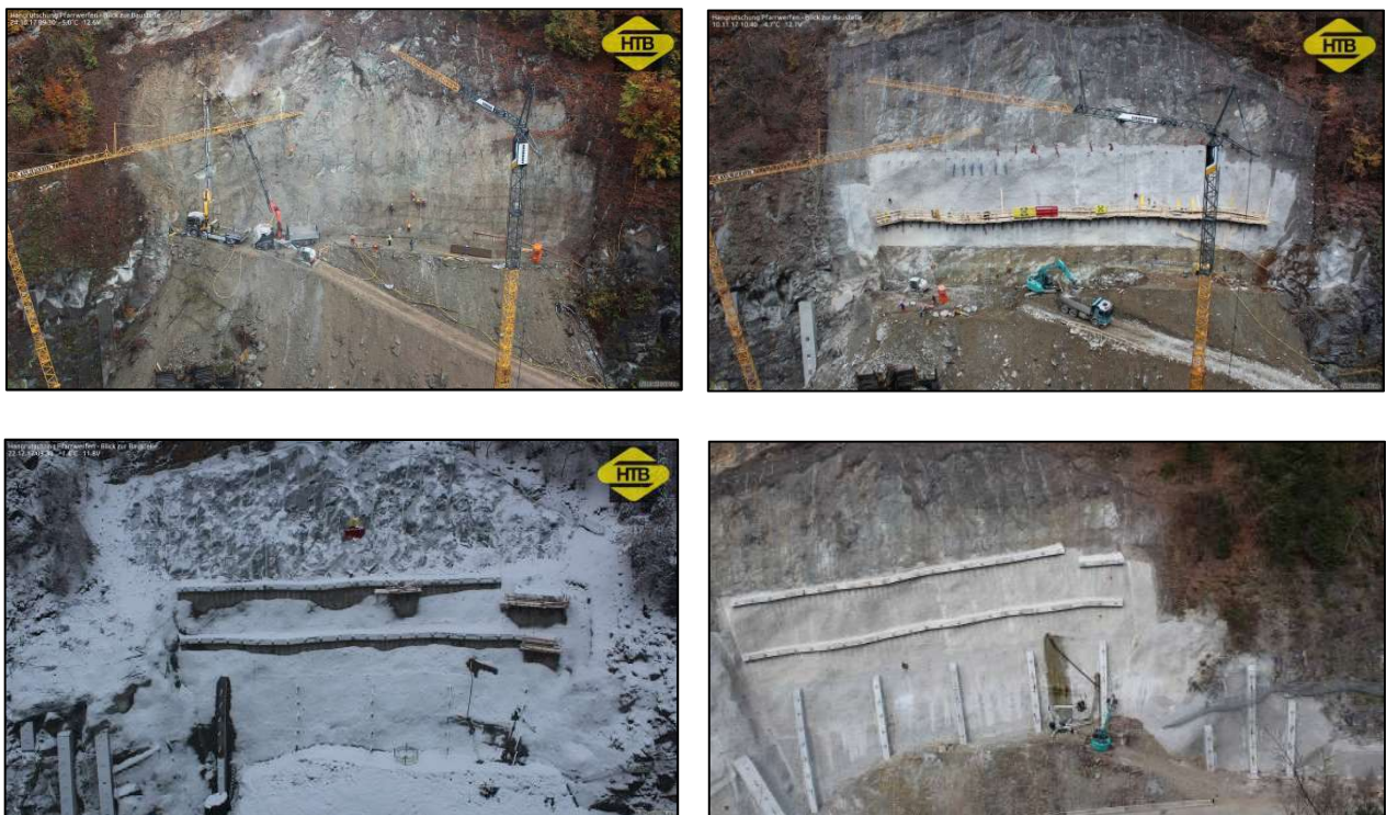
Abb. 7: Bauablauf (Webcam HTB)
