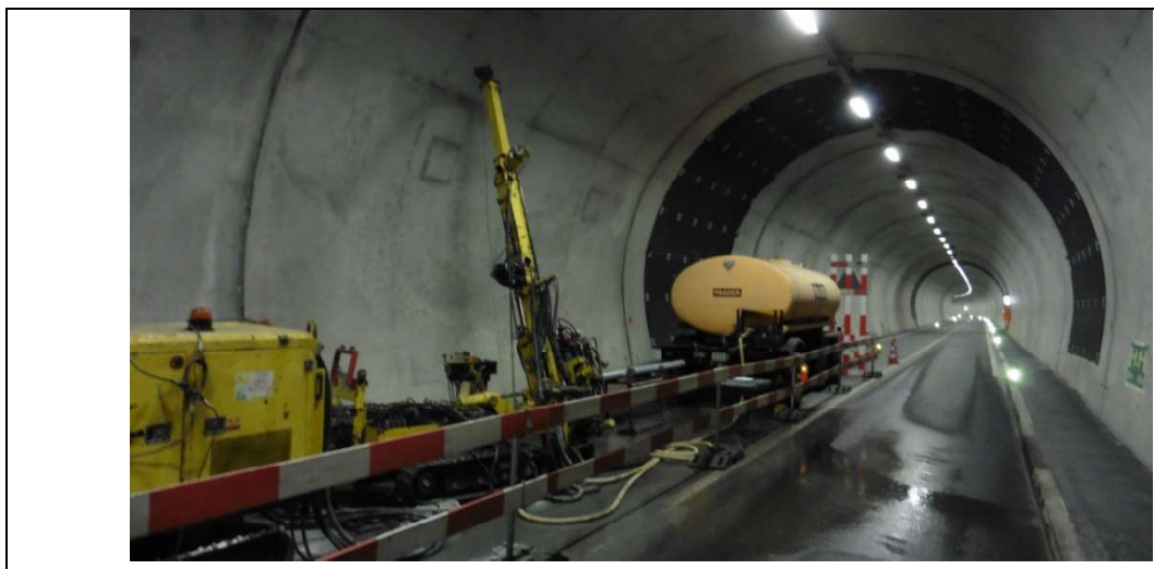
Abb. 1: In den zwei ~ 7 m breiten, 50 m auseinander liegenden Deformationszonen mussten die Risse im Beton mit Netzen und Ankern gesichert werden; Ausführung der Bohrung SB 1 bis in 24 m Tiefe unter die Tunnelsohle.
