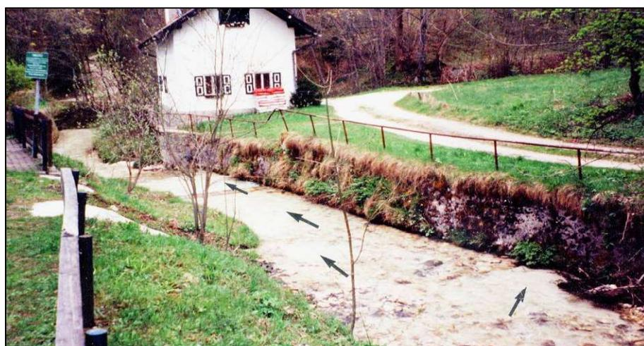
**Abb. 3:** Weißbach vor der Mündung in den Mesnerbach mit Wasseraustritten aus der Sohle (8) mit Erdfällen und starke, getriebte Austritte an der Sohlschwelle (9) und der Auslauf der „Drainage Pliem“ (10).
