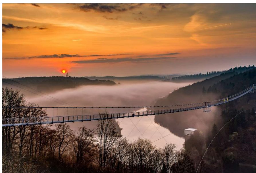
Abb.8: Hängebrücke Rappodetalsperre in der Dämmerung
