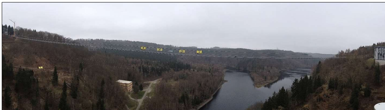
Abb.7: Hängebrücke mit einer Länge von 458 Metern neben der Rappodetalsperre
