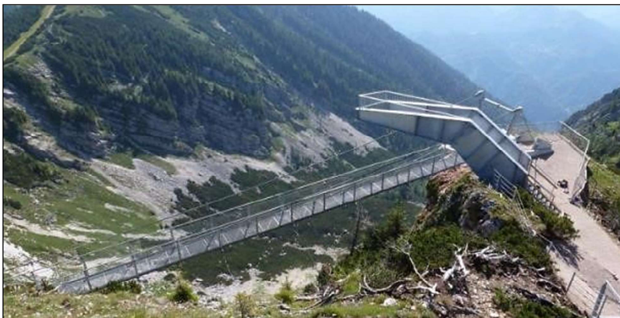
Abb.11: Aussichtsplattform und Hängebrücke Hochkar
