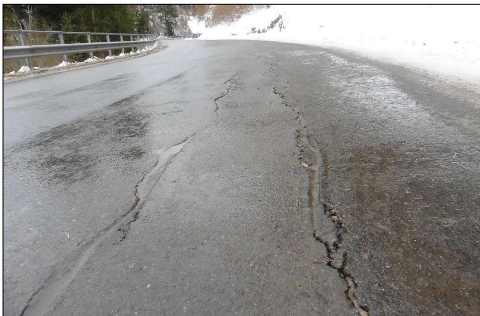
**Abb. 1:** Jährlich hinter der Lehnenbrücke Sandkehr West sich öffnende Risse.
