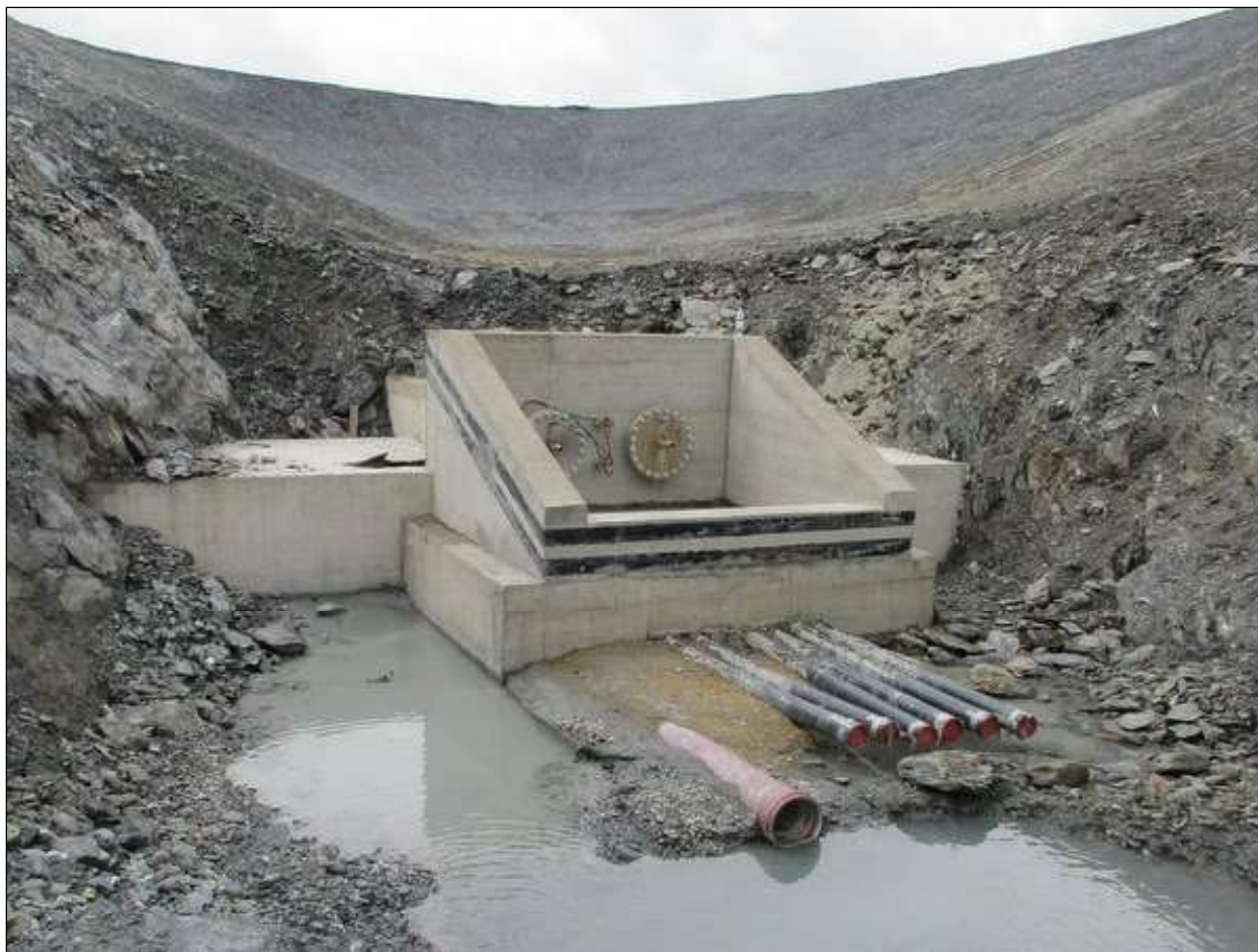
Abb. 8: Betondichriegel beim Entnahmebauwerk sowie temporäre Ausleitung der Oberflächenwässer
