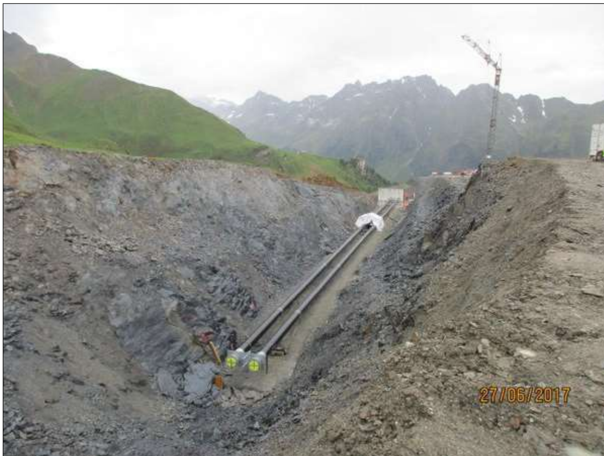
Abb. 6: Entnahmegraben von Entnahmebauwerk zu Vorpumpstation
