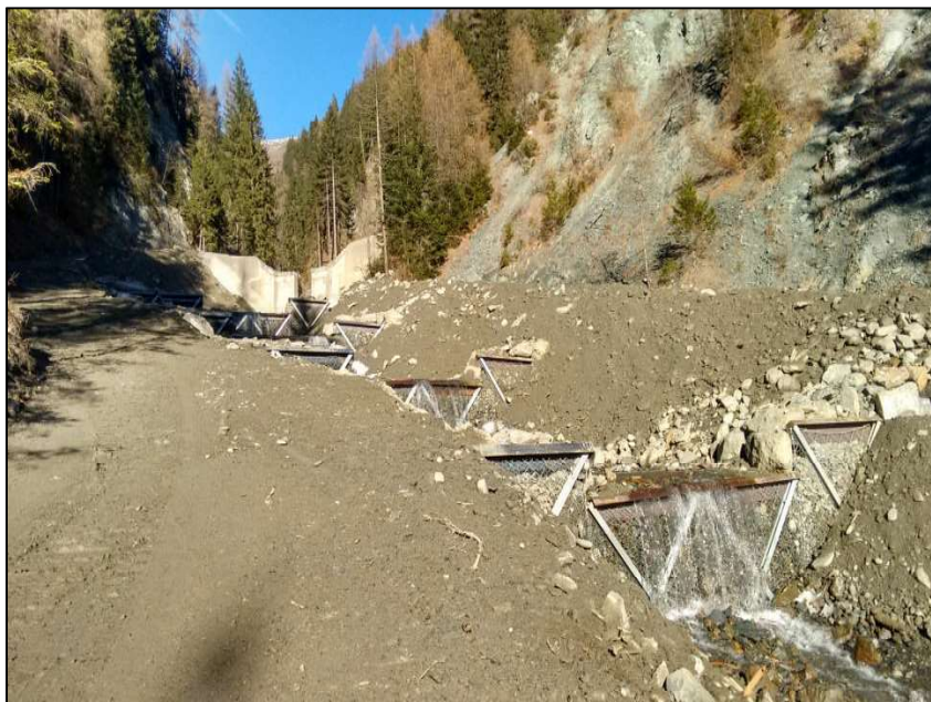
Abb. 4: Vermeidung von Sohleintiefung
