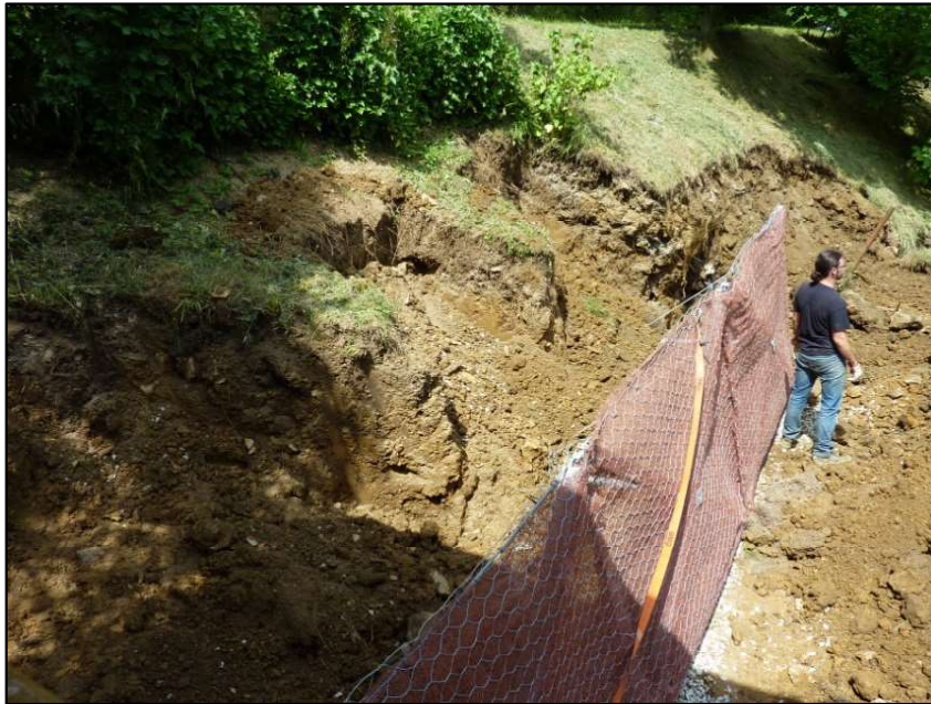
Abb.9: Einbau der junior-Elemente
