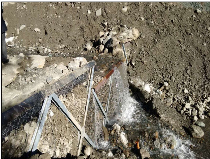
Abb. 5: Kantenschutz mit unverzinktem Blech – modulare Bauweise
