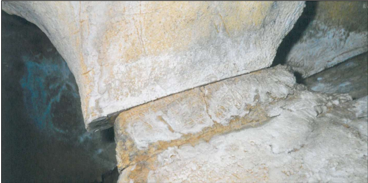
Foto: „Pfeilerbruch“ im Altherrenlabyrinth.
