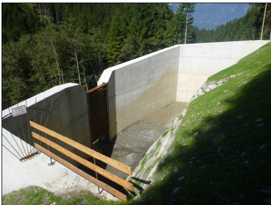
Abbildung 3: Im September 2016 konnten die Sicherungsmaßnahmen fertiggestellt werden.
