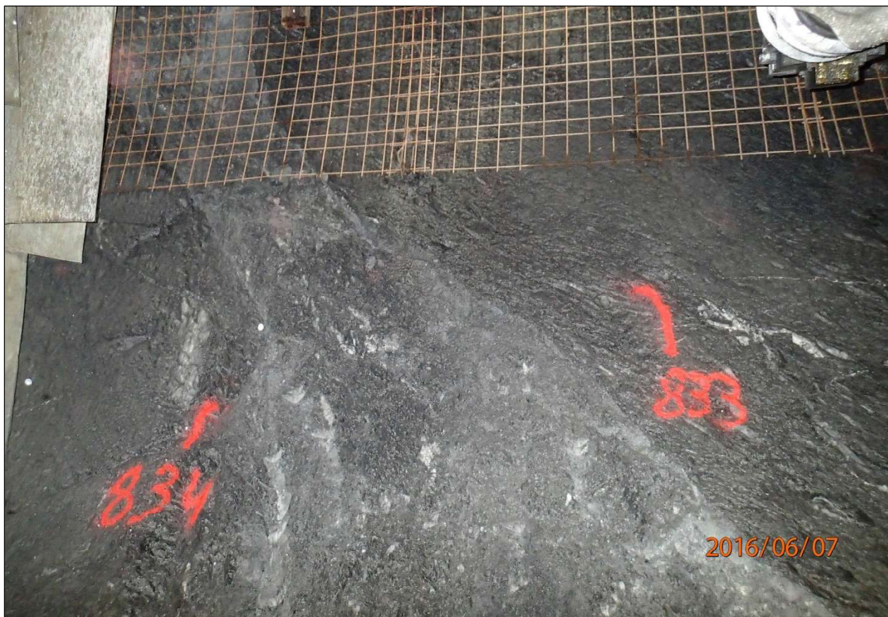
Abb. 8: Foto einer schleifenden, mittelsteil nach W einfallenden Störungs-Kernzone mit variierender Mächtigkeit und Zusammensetzung im Bereich der rechten unteren Tunnellaibung im TBM-Vortrieb bei Projektkilometer 8,38
