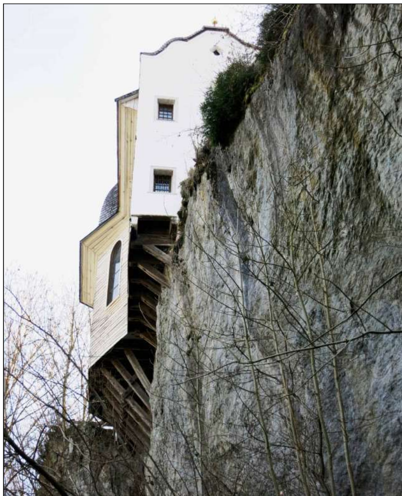
Abb. 5: Senkrechte bis 20 m hohe Abbruchwand unterhalb der Kirche Maria Rast
