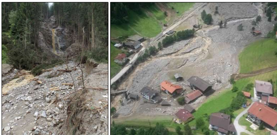
Abb. 4: Blick vom Schwemmkegel in die steile Schluchtstrecke des Seigesbaches am Morgen des 8. Juni 2015, das Einlaufgerinne wurde gänzlich zerstört (Jenner, 2015).
