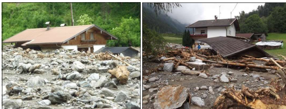
Abb. 1 (li.): Bis zum Dachstuhl eingeschüttetes Haus im Mündungsbereich des Ellmauerbaches durch die Prozessaktivität des Seigesbaches (Jenner, 2015).
