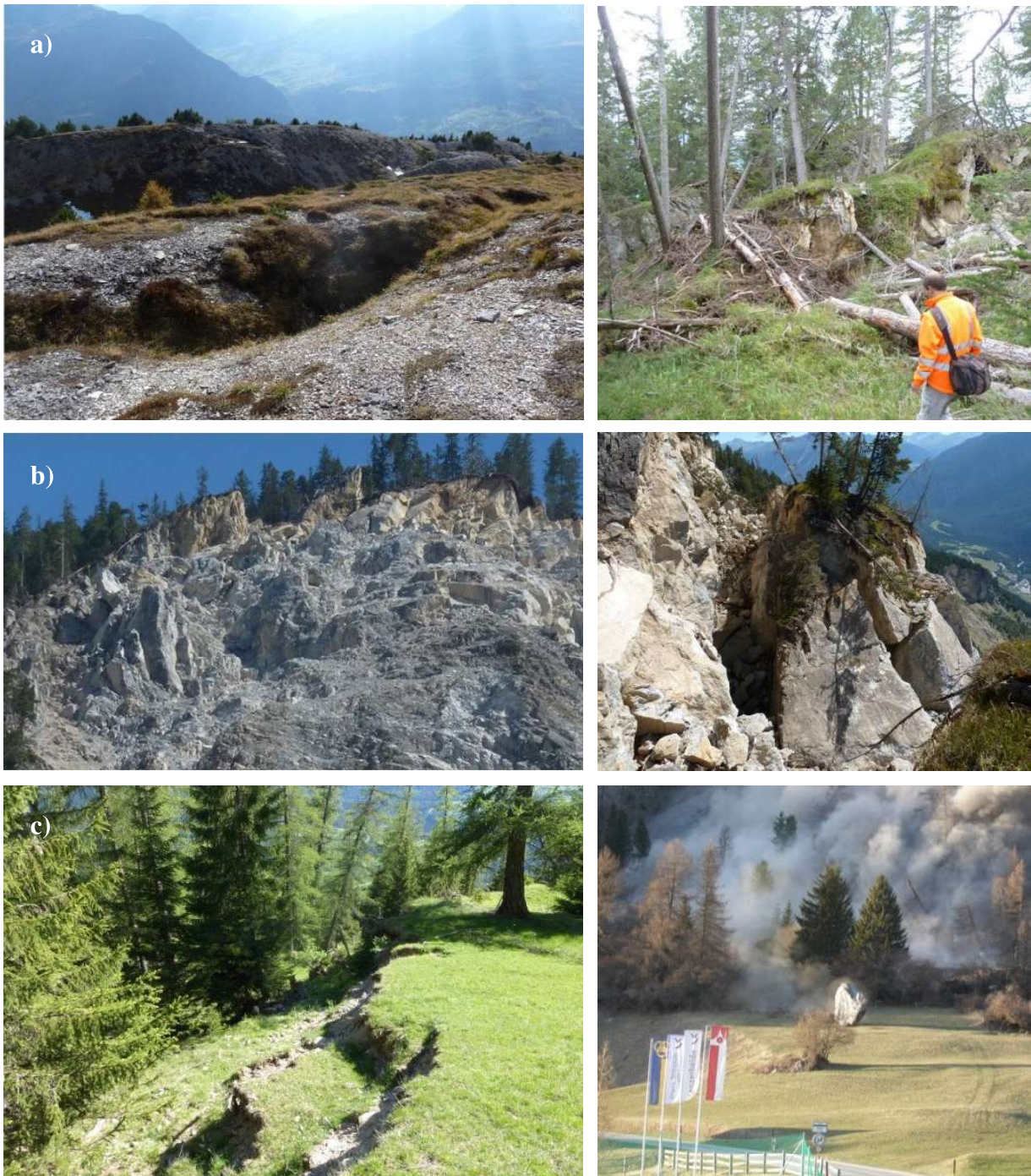
Abb. 8: a) Nackentäler im obersten Anriss Gebiet der Massenbewegung und rechts im Bild, Toppling im Felsen oberhalb des aktiven Felsabbruchs; b) aktiver Felsabbruchrand oberhalb von Brienz mit Verschiebungsraten bis zu 2 m/Jahr; c) westlicher Rand des Brienzler Rutsches und rechts im Bild, Felssturz mit hochenergetischem 50 m 3 Sturzblock, der vor der Straße zum Stillstand kam.
