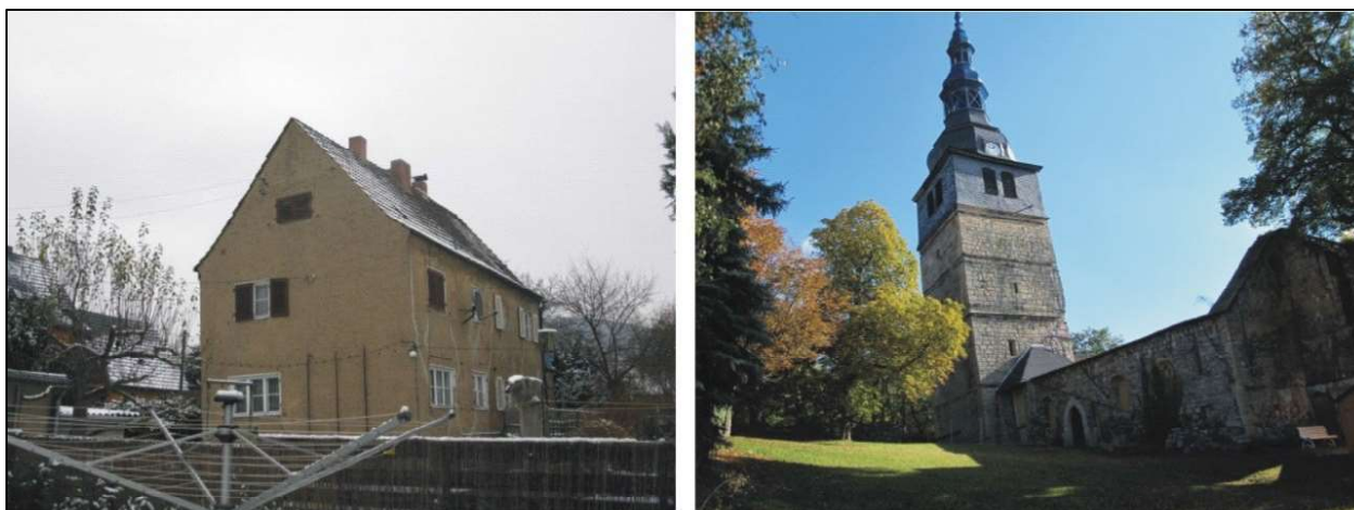
Abb. 6: Die langsame Auslaugung von Sulfatgesteinen führte in Jena zu einer, mit umfangreichen Rissen verbundenen Schrägstellung eines Gebäudes, so dass die örtlichen Baubehörden eine Räumung anordnen mussten (links). Die Neigung des schiefen Turms der Oberkirche in Bad Frankenhausen nimmt durch kontinuierliche Sulfat- und Steinsalzauflösung im Untergrund beständig zu und zeigt seit ca. 100 Jahren eine stetige dynamische Beschleunigung (rechts).
