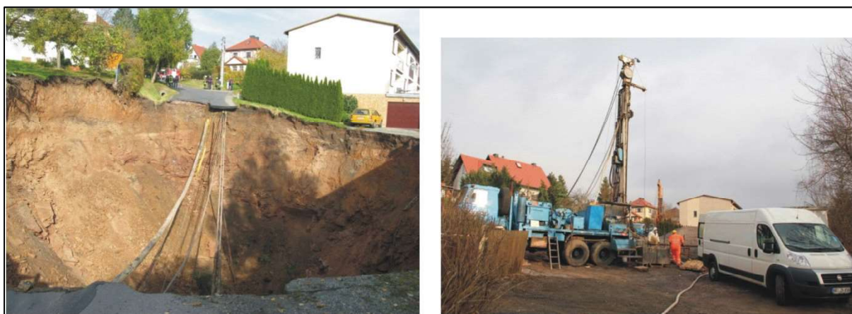
Abb. 5: Nach dem Erdfall in Schmalkalden am 01. November 2010 mussten 5 Häuser z. T. zeitweilig evakuiert werden (links). Im Umfeld des inzwischen mit Kies verfüllten Erdfalls wurden im Januar 2011 zur Ursachenermittlung 4 Kernbohrungen mit 2 Bohrgeräten in bis zu 150 m Tiefe gestoßen (rechts).
