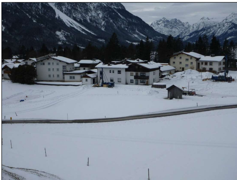
Abb.2: Übersicht über die Bohrungen im Ortsgebiet von Weißenbach im Zuge der Untergrunderkundungen. Jene Bohrung, bei der es zu einem Gasaustritt kam, befindet sich in der rechten Bildhälfte neben dem Holzstadel.
