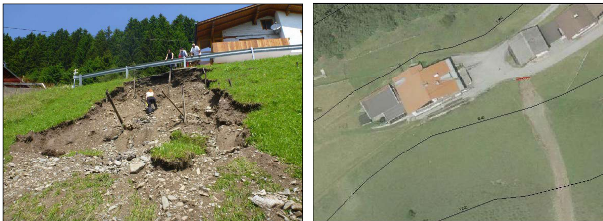
Abb. 10: Hangexplosion ca. 5-6 m breit im Siedlungsgebiet, Ortsteil Perfall auf 1250 müA unterhalb der Straßenböschung: links Aufschlussfoto (Quelle: Landesgeologie), rechts Ausschnitt Orthofoto nach Unwetter
