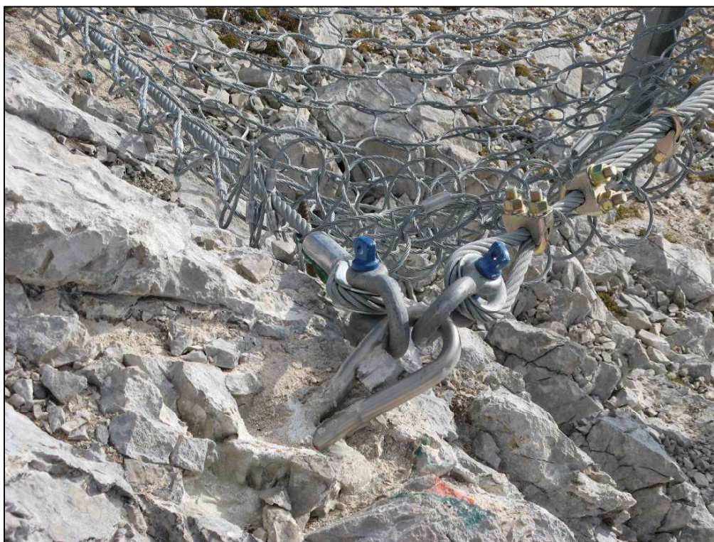
Abb. 11: Seilankerkopf im Detail.
