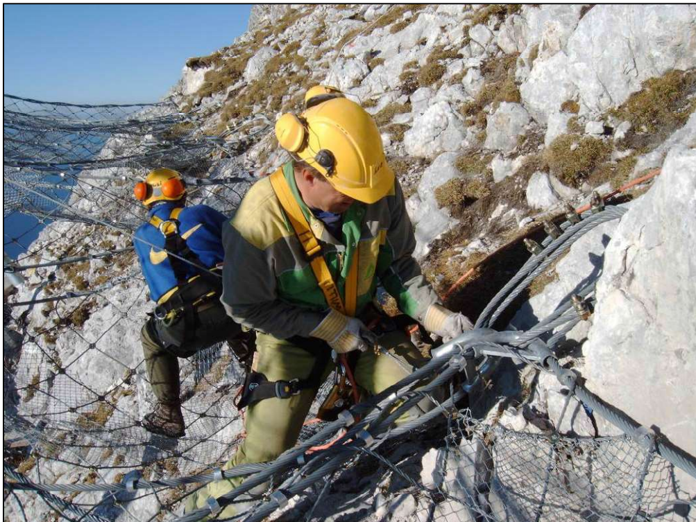
Abb. 9: Fixierung des Netzes am bergseitigen Seilanker mit Verbindungsseilen.
