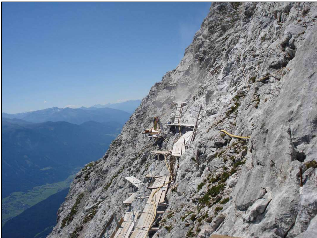
Abb. 7: Baustellenhilfseinrichtung in Form von Holzwegen entlang der Bohrebenen
