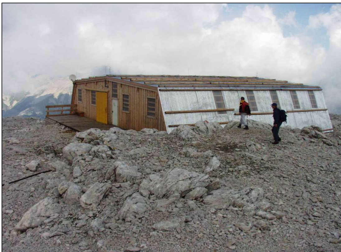
Abb. 5: Baustellenlager und Unterkunft auf dem Gipfelplateau der Hohen Munde
