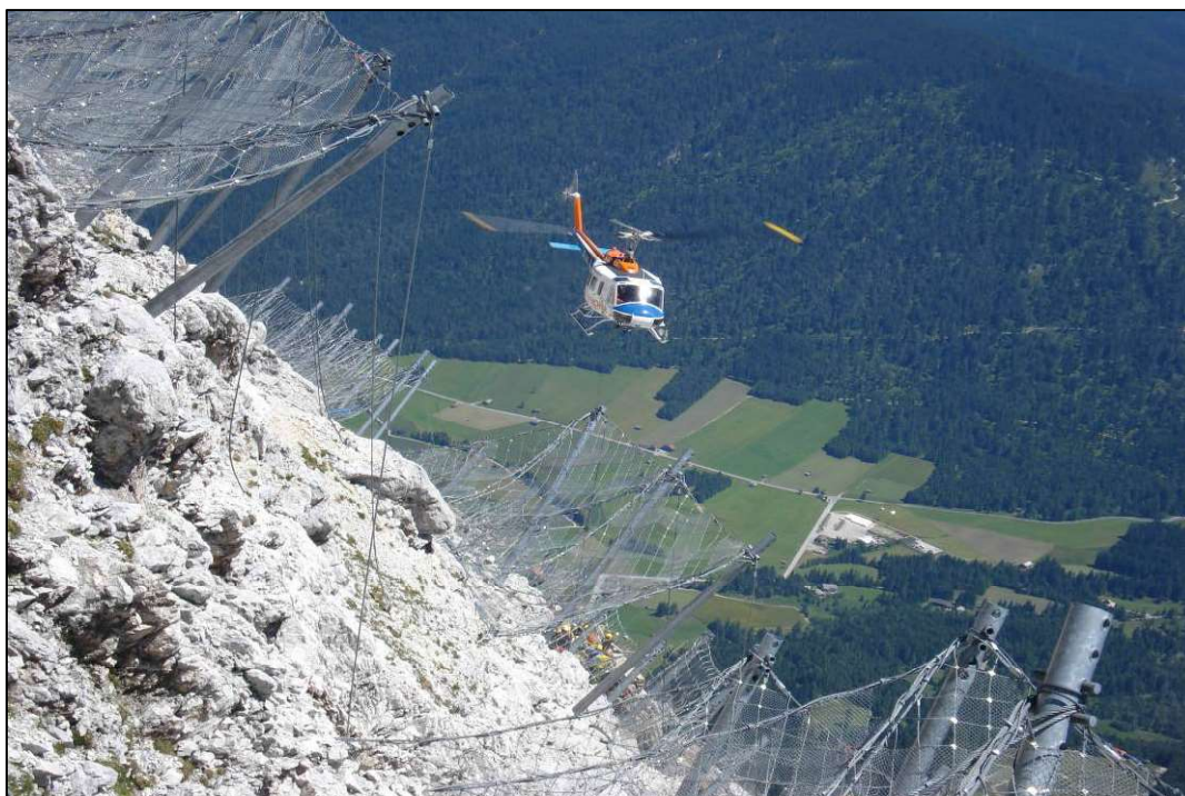
Abb. 10: Transport der Netze mittels Hubschrauber
