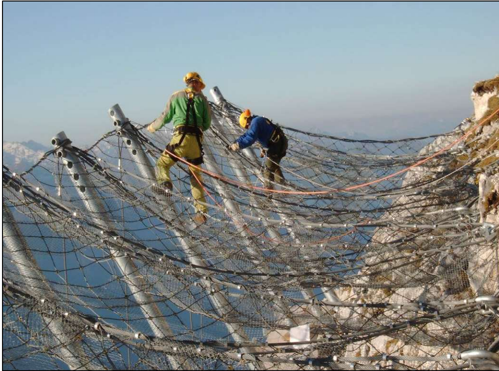
Abb. 6: Endmontage von GEOBRUGG Netzen
