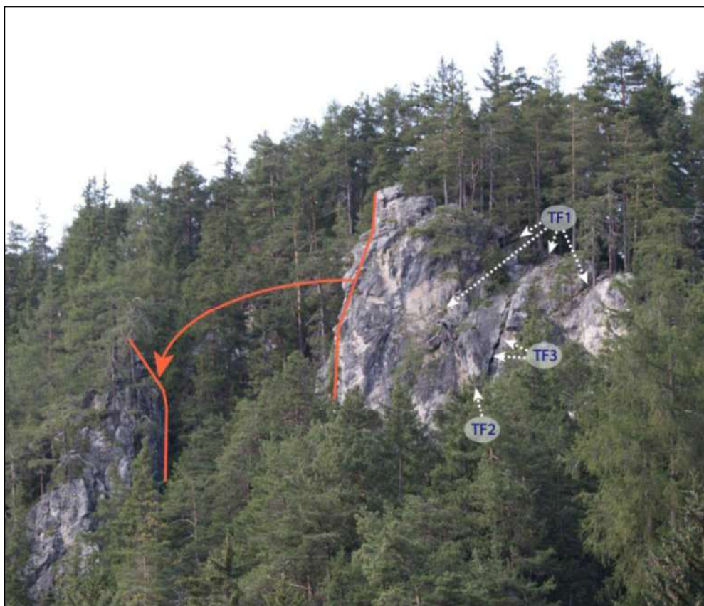
Abbildung 53: Abfahren einer turmartigen Klippe, sowie die gekennzeichneten typischen Trennflächensysteme (TF) am Randbereich des Systems „Hart auf Weich“ nach Poisel u. Eppensteiner (1988; 1989)
