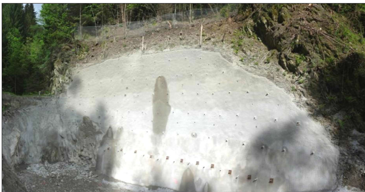
Abbildung 45: Fertiggestellte Baugrube mit geänderter Baugrubensicherung
