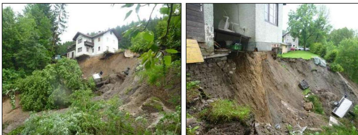
**Abb. 5** Hangrutsch in Kirchbichl, der zur Freilegung des Fundamentes und zum Abriss des Gebäudes geführt hat
