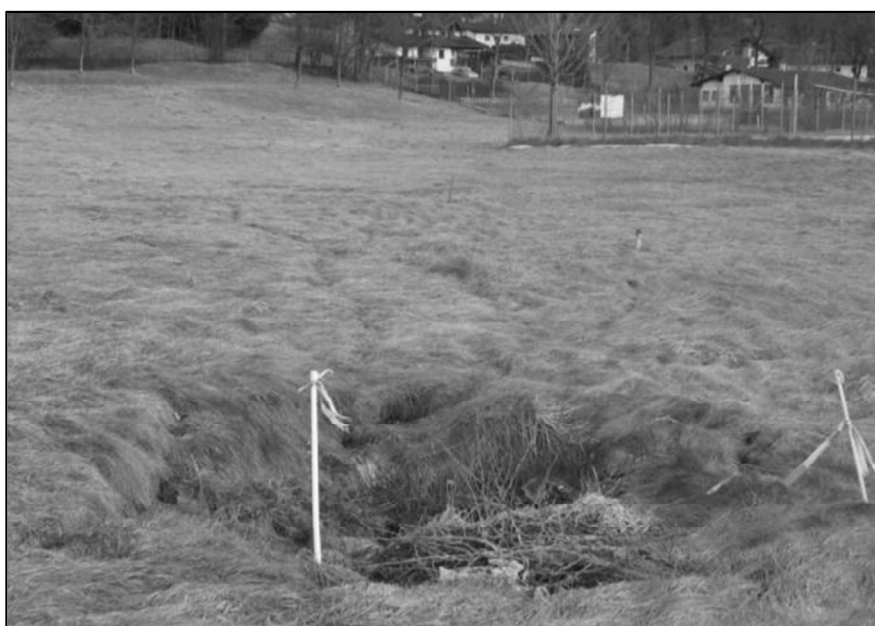
Abb. 6: Erdfall auf dem Areal des geplanten Freischwimmbades
