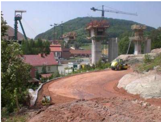
Bild 46: Stützwand im Bau (mit Brücke und angrenzenden Gebäuden)
