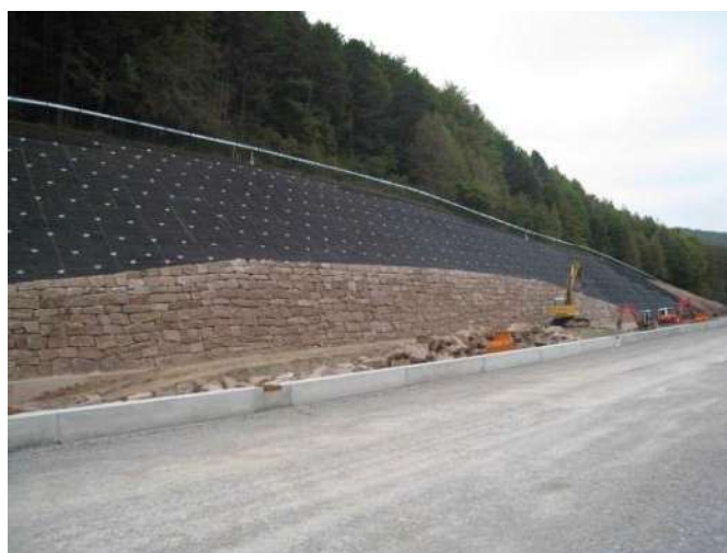
Bild 36: Stützkonstruktion an BAB A38 Egelskopf
