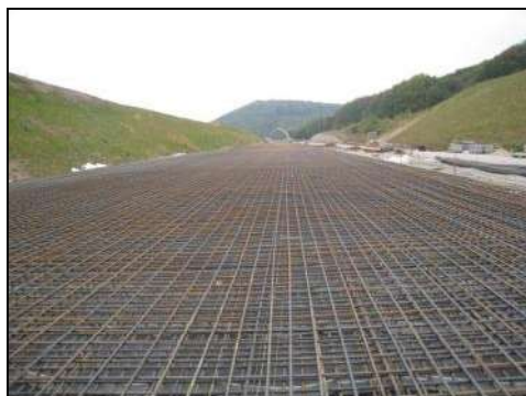
Bild 42: Bewehrung Erdfall- schutzplatte
