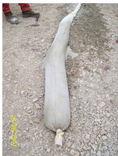
Bild 39: Verpress-Strumpf
