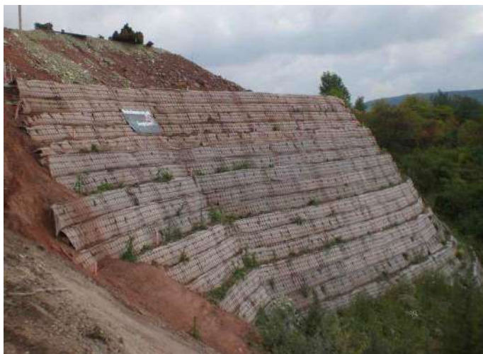
Bild 49: Fertige Wand nach Herstellung
