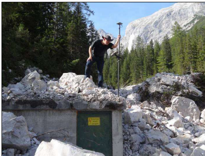
Abb. 2: Einmessen der „Ground Control Points“ – hier am Beispiel eines natürlichen Punktes an der Dachkante des teilweise verschütteten Generatorhauses.
