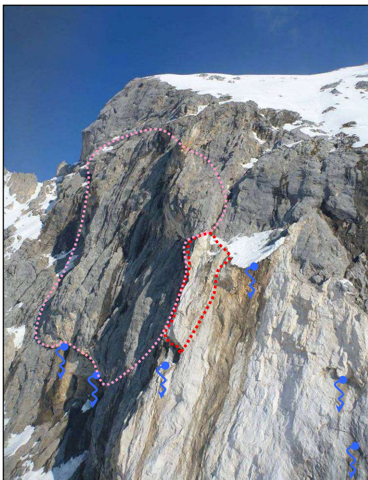
Abb.8. Oberer Bereich der Abbruchstelle mit Wasseraustritten aus Trennflächen und verkarsteten Bereichen. Potentiell absturzgefährdeter Bereich der durch offene Kluft getrennt ist (rot). Überhängenden Bereiche mit Wasseraustritten an steil stehenden bergausfallenden Trennflächen, die langfristig potentielle Gefährdungsbereiche darstellen (rosa).
