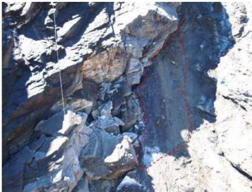
Abb. 32: Detail Ablösebereich des Felssturzes
