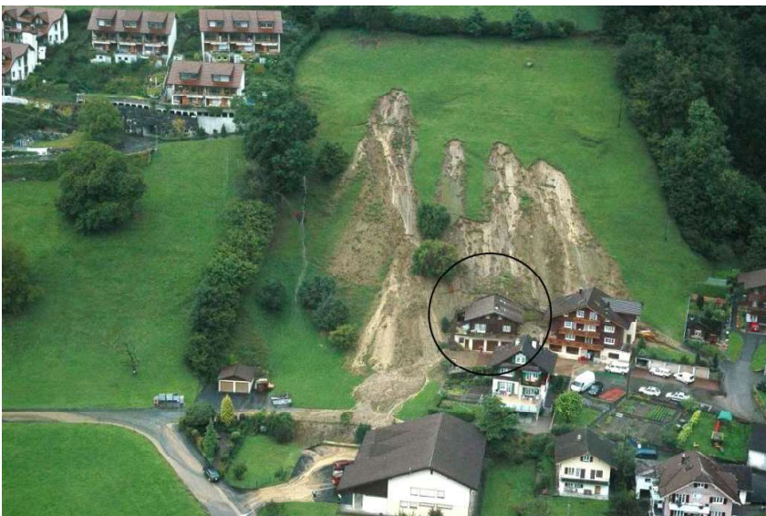
Abb. 1: Mehrere Hangmuren treffen auf Wohnhäuser in Alpnachstad
