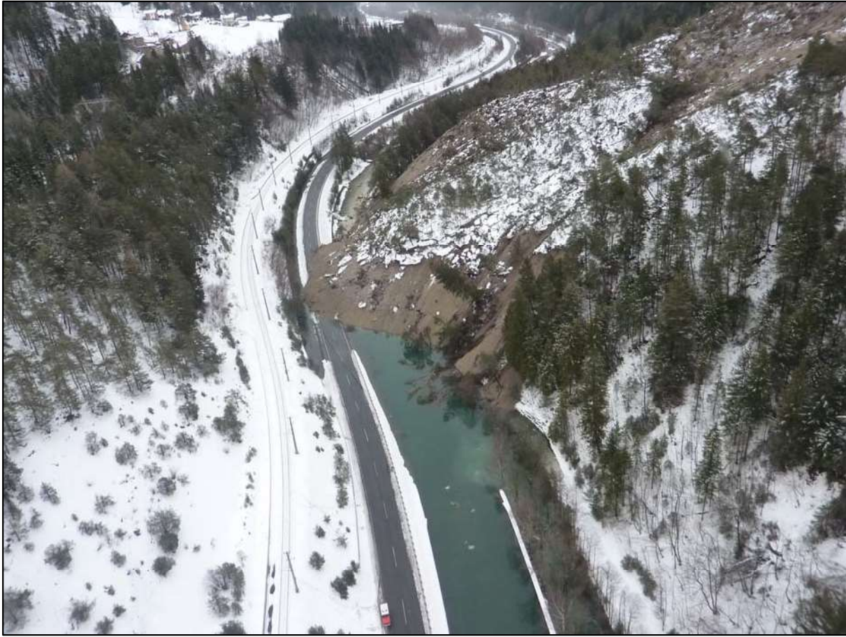
Abb.2.: Stirnbereich der Rutschmasse mit Blickrichtung Osten. Gut ersichtlich sind der Einstau der Drau und die verschüttete Landesstraße. Links daneben verläuft die Bahnlinie (Foto Baubezirksamt Lienz).
