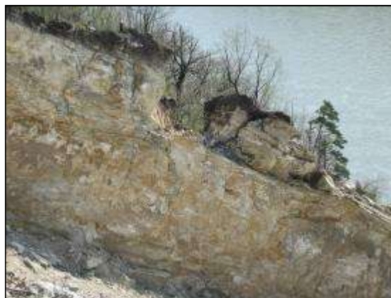
Reste vom Felssturz 2006
