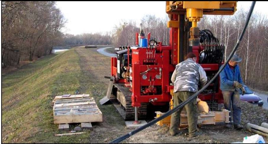
Abb. 2: Erkundungsbohrungen am Donauhochwasserschutzdamm im Auftrag der ARC-sr.
