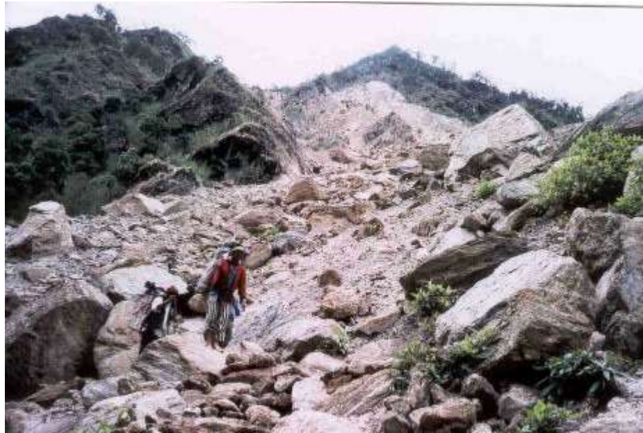
Abb. 20: Im unmittelbaren Bereich der MCT im untersten Langtangtal mehrt sich die Fels- und Bergsturz­häufigkeit in den stark tektonisierten Gneisen. Diese 1984 entstandene Felslawine nahe dem nach ihr benannten Landslide Lodge (Touristenherberge) mit einem Volumen von 50.000 Kubikmeter forderte entlang der Haupttrekkingroute ein Todesopfer (Foto: J.T. Weidinger, 1990).
