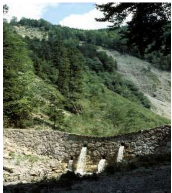
Abb. 2: Die im Jahre 1985 fertiggestellte Konsolidierungssperre (a). Risse im rechten Flügelderselben Sperre im Jahre 1987 (b).
