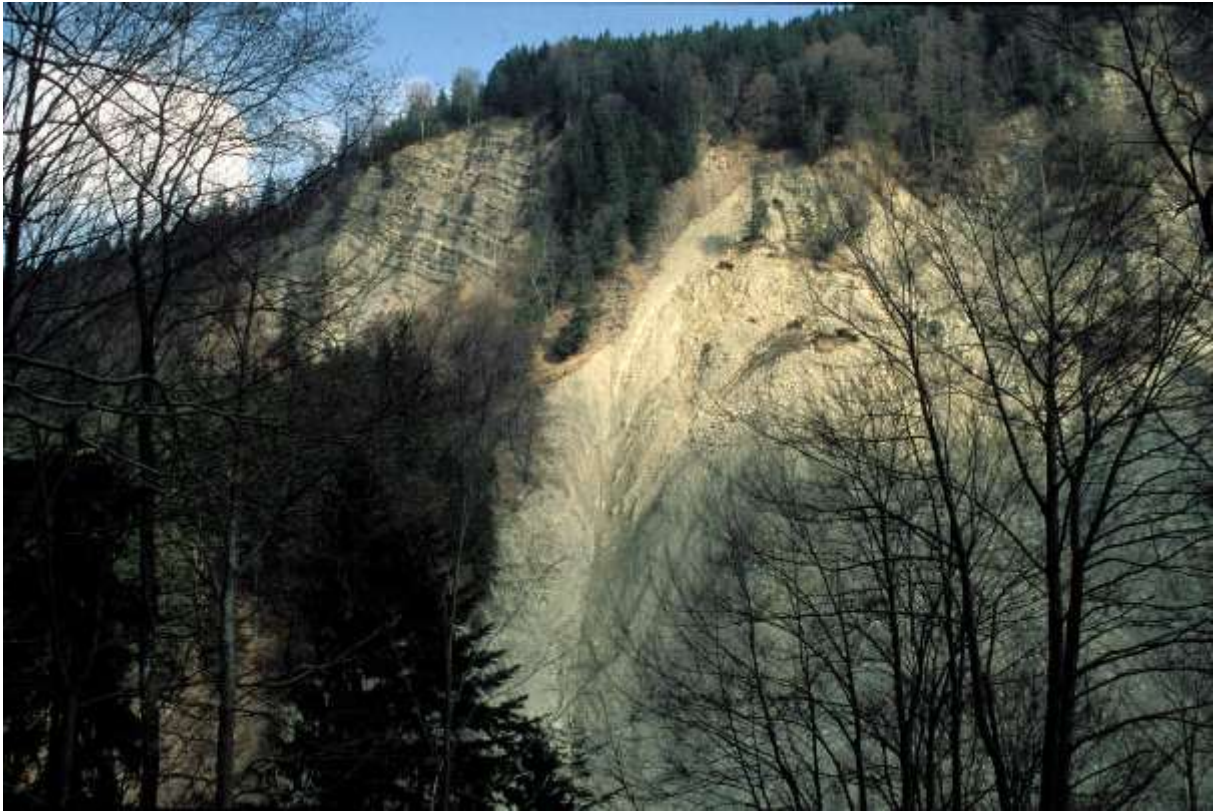
Abb. 3: Die Hangbewegung „Brechries“ am Jenbach. Links im Bild ist die Lagerung der Kalkmergel deutlich zu sehen. Im Bildvordergrund der Anbruch aus dem Jahre 1998, der links (Bildmitte) von der Brechries-Reiße begrenzt wird.
