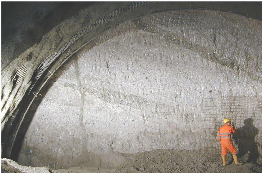
**Abb. 4:** Störungen und Spalten in den verkitteten Deltasedimenten des Vomperbaches, Foto bei TM 20,6 im Vortrieb Vomp Ost.
