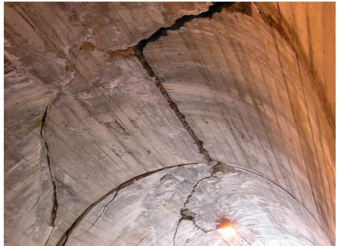
Fig. 1: Seit 1995 ereigneten sich jährlich Block- und Felsstürze. Durch die Entfestigung der Felsrippe wurde das Tunnelgewölbe stark zerrissen
