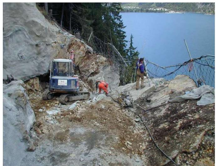
Fig. 13: Lago di Poschiavo: Nach Versetzen der Extensometer (E1-E3), nach Teilabtrag und Ausführung der Ankerarbeiten zeigt das geologische Befundprofil hinter der ~ 5-7m starken Felswand ein Hauffwerk von Blöcken mit grossen Hohlräumen. Die dahinter folgende Felswand ist mit offenen Talklüften K4 zerlegt.
